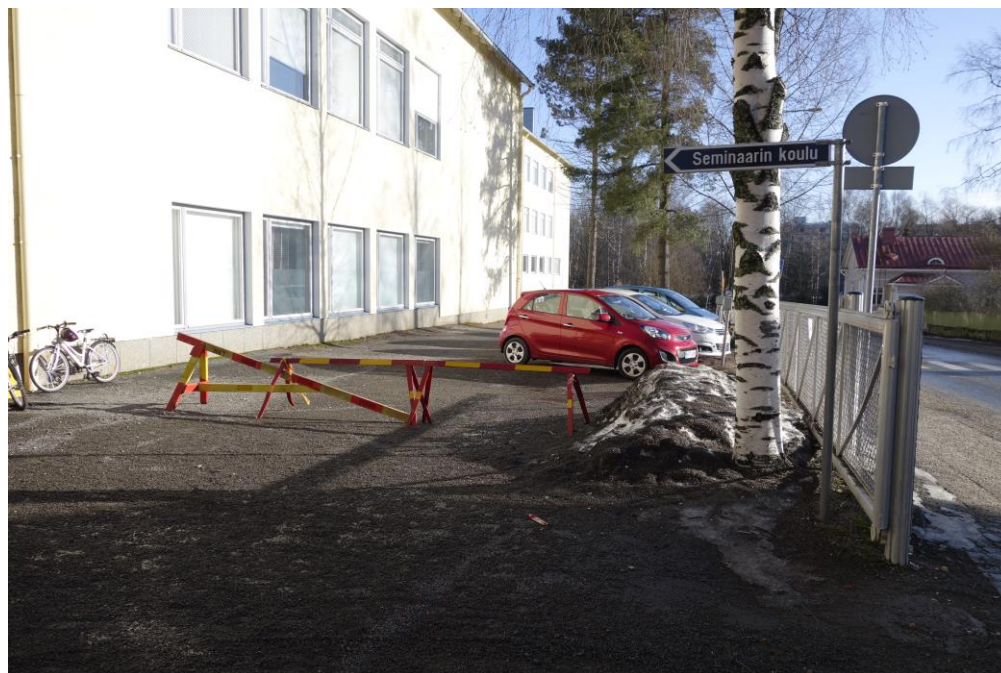
Kuva 10 Seminaarinkadun este läpiajolle
