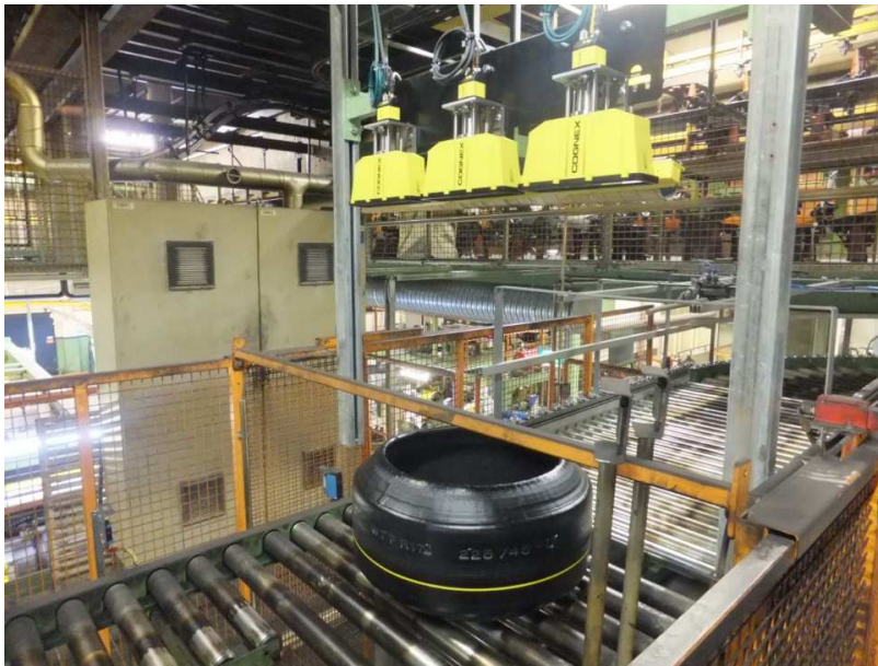
KUVA 7. Viivakoodikamerajärjestelmä asennettuna välivaraston tulokuljettimelle (Juho Pulakka 2015)
