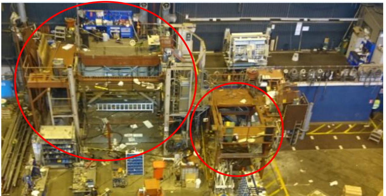
KUVA 17. Koeajopukit ja sähköosasto
