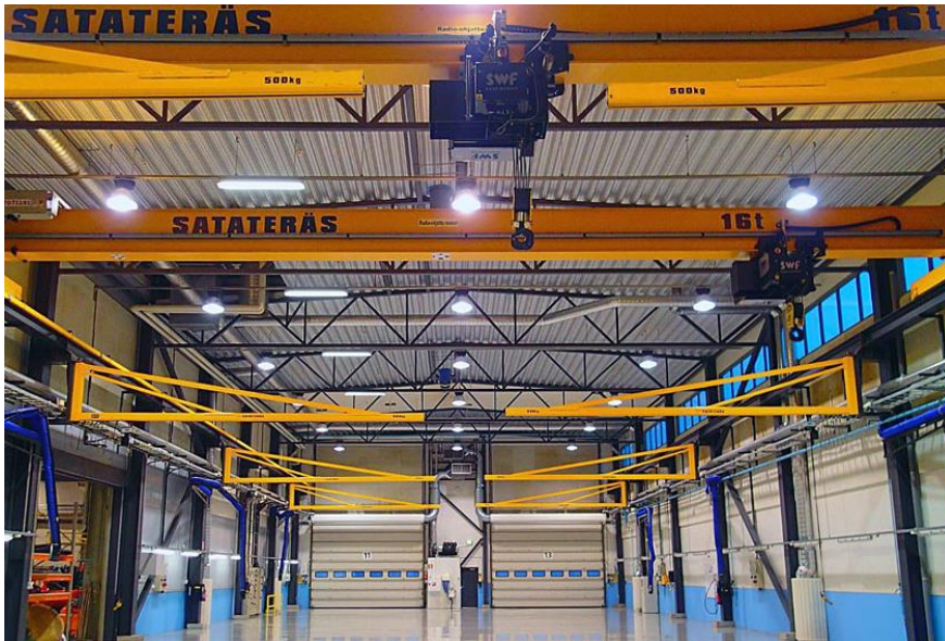
KUVA 24. Siltanostureiden ja kääntöpuominostureiden yhdistelmä (Satateräs Oy. kuvagalleria 2015)
