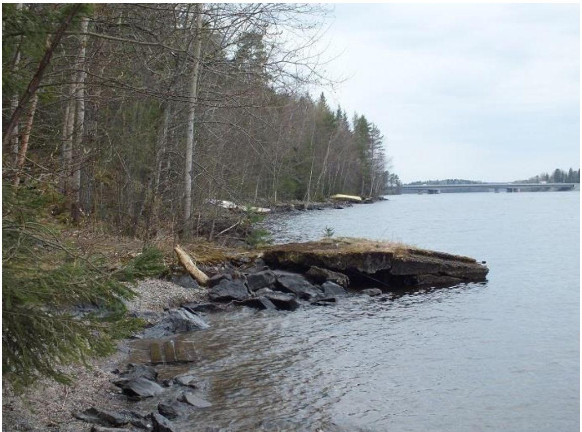
KUVA 19. Turrin vanha laiturirakennelma. Taustalla poistettavia luonnonomaisia soutuvenepaikkoja.
