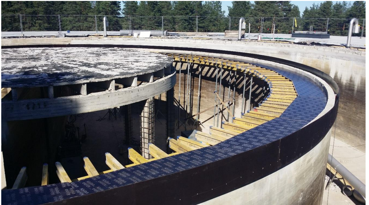
Kuva 10 Keskeneräinen muotti
