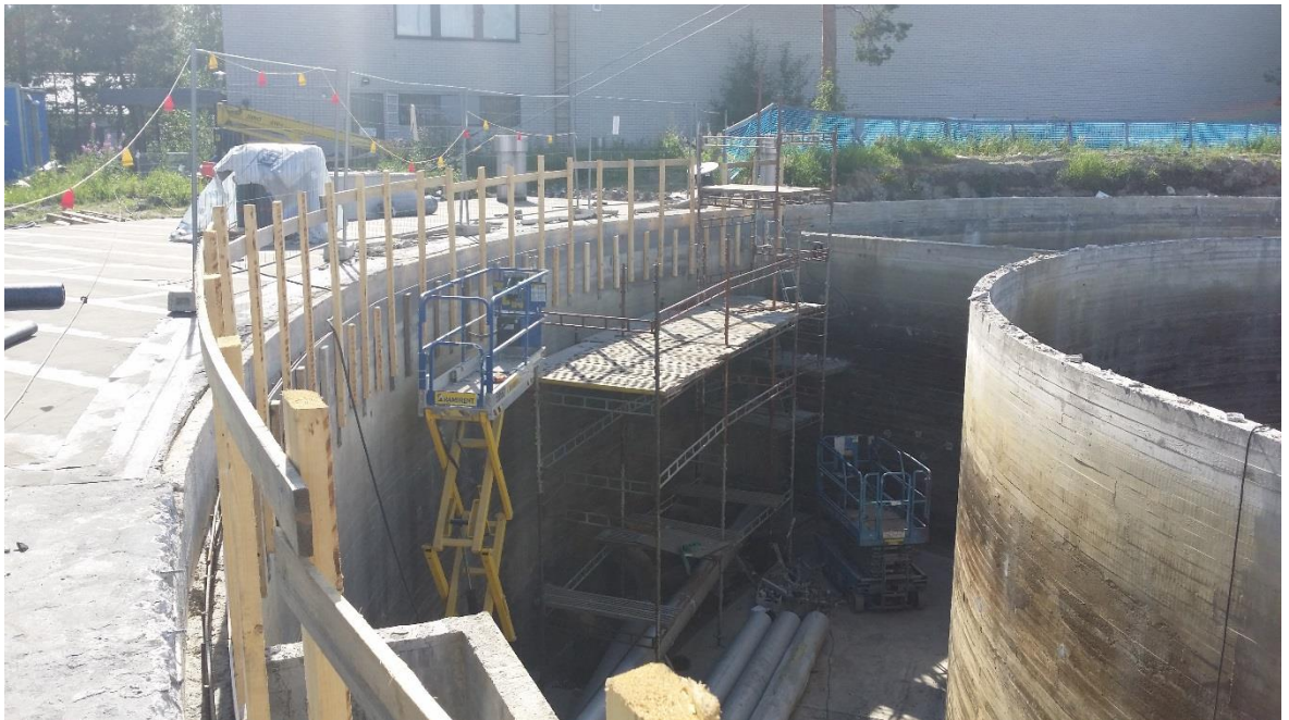
Kuva 5. Ulkoseinän keskeneräinen muotitus, sekä suoja-kaide.
