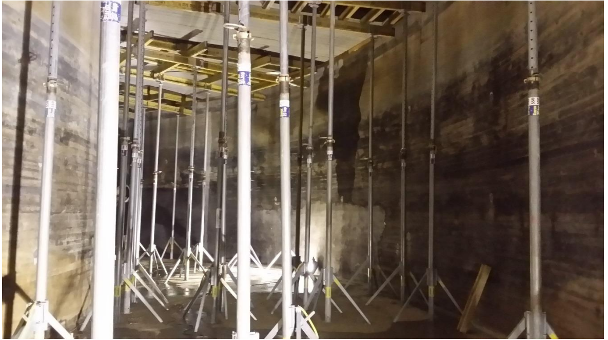
Kuva 13. Valmiita holvimuotteja.
