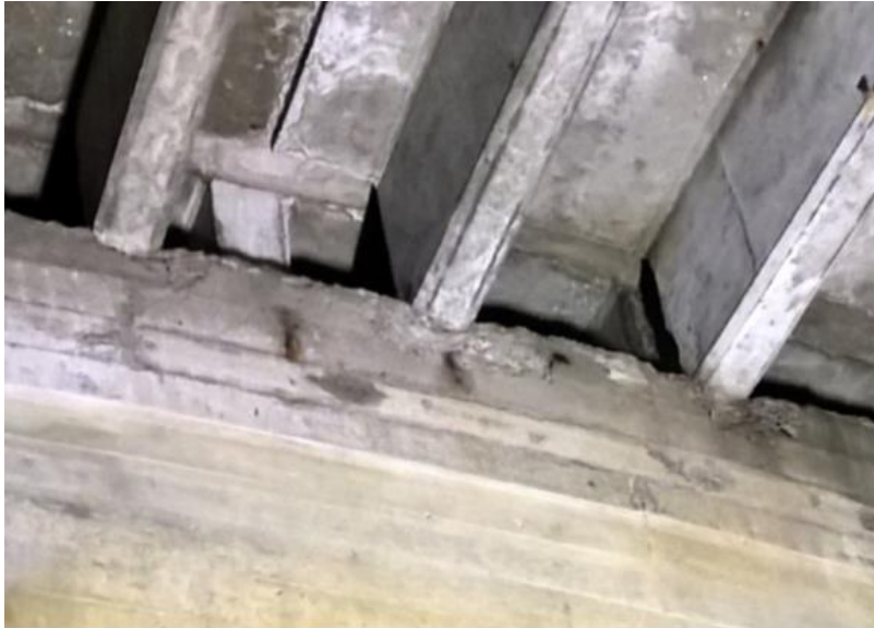
Kuva 2. Väliseinän vaurioita
