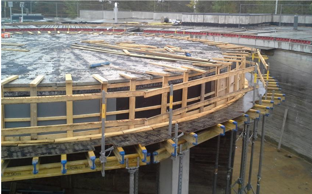
Kuva 11. Ympyräpalkin muotti.
