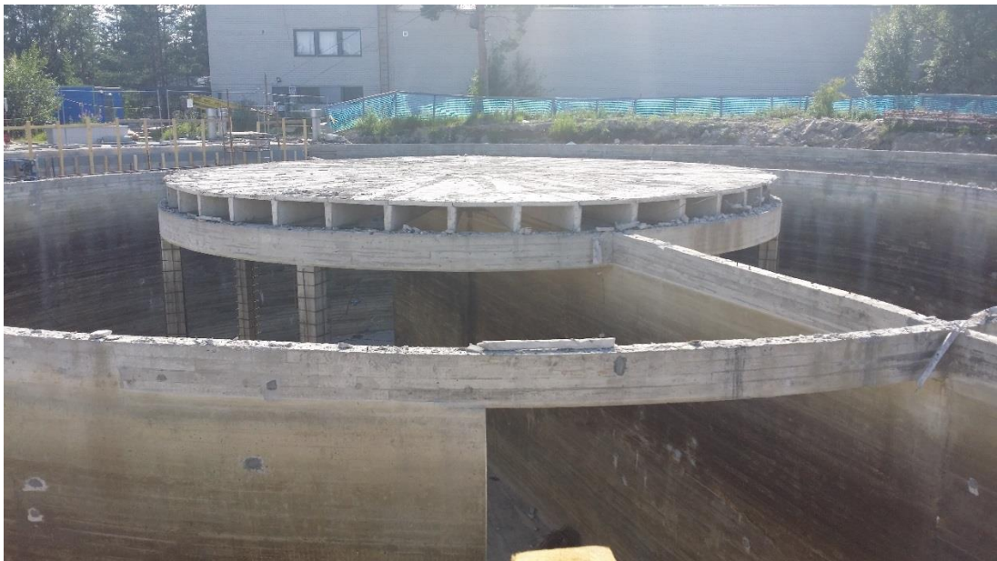
Kuva 6. Säiliön kansi.
