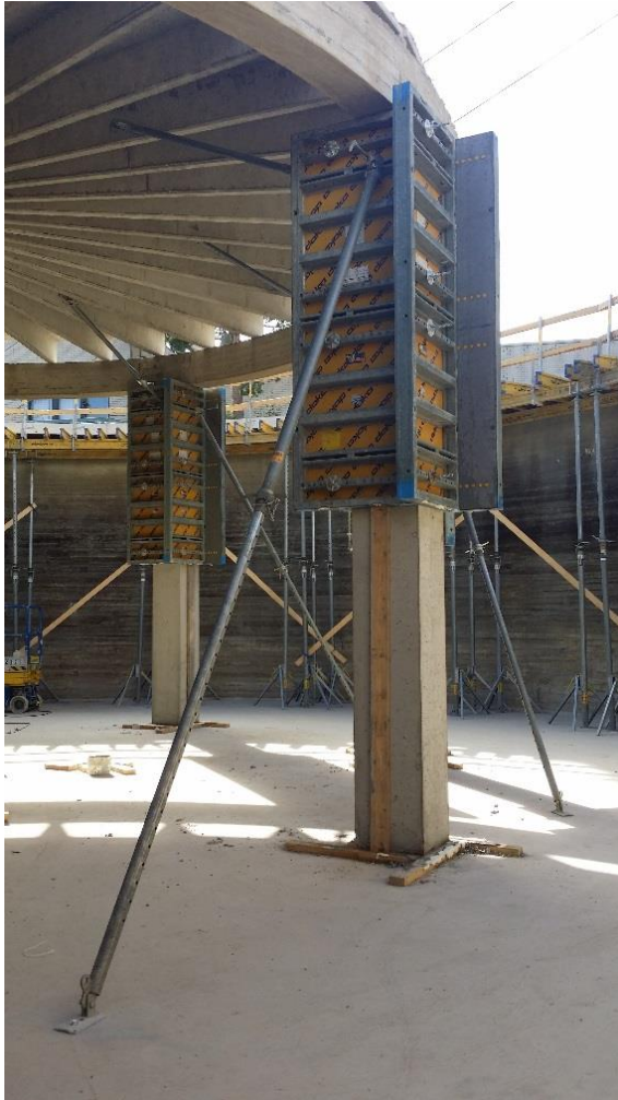
Kuva 9 Pilareiden yläosan manttelointi
