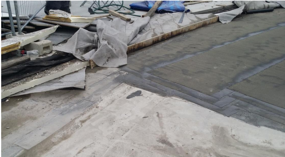
Kuva 15. Vanhan säiliön ja laajennusosan vesieristeen liitos.
