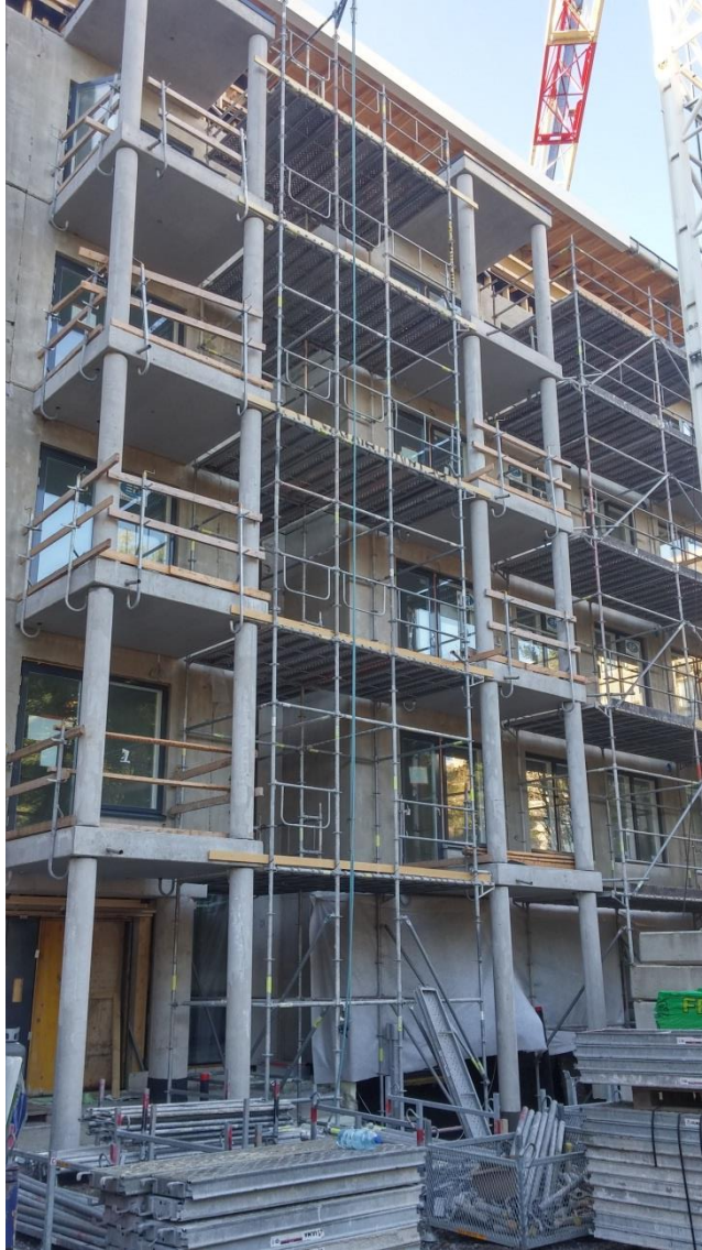
Kuva 4. Rappaustelineiden pystytystä.
