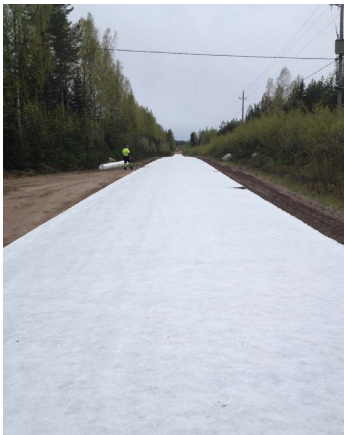
Kuva 4. N3-luokan suodatinkangas valmiiksi levitettynä murskeen ajoa varten (Rissanen 2015-05-25)
