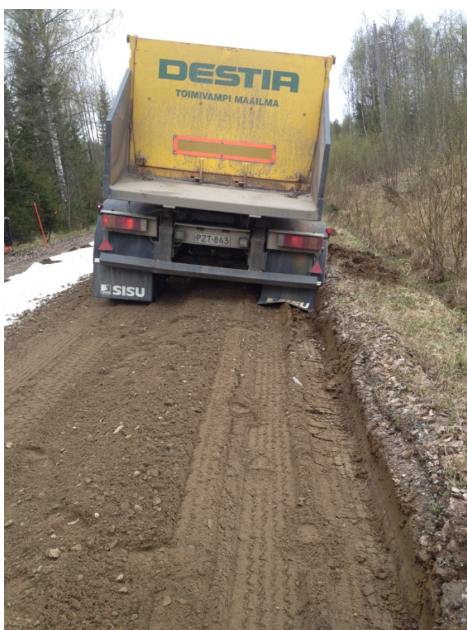
Kuva 2. Kelirikkokohteen parannusta tehtäessä keväällä 2015 Vesannon Oinaskylällä murskeen ajossa ollut kuorma-auto upposi pehmeään tiehen. (Rissanen 2015-05-18)
