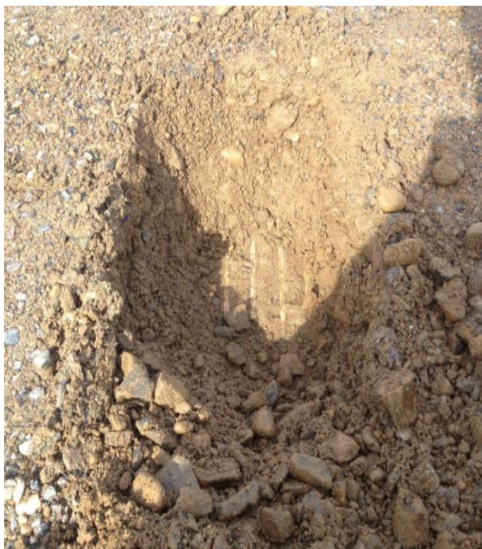
Kuva 5. Kuvassa näkyy geoverkkomattoa kuopan pohjalla (Rissanen 2015-26-5)
