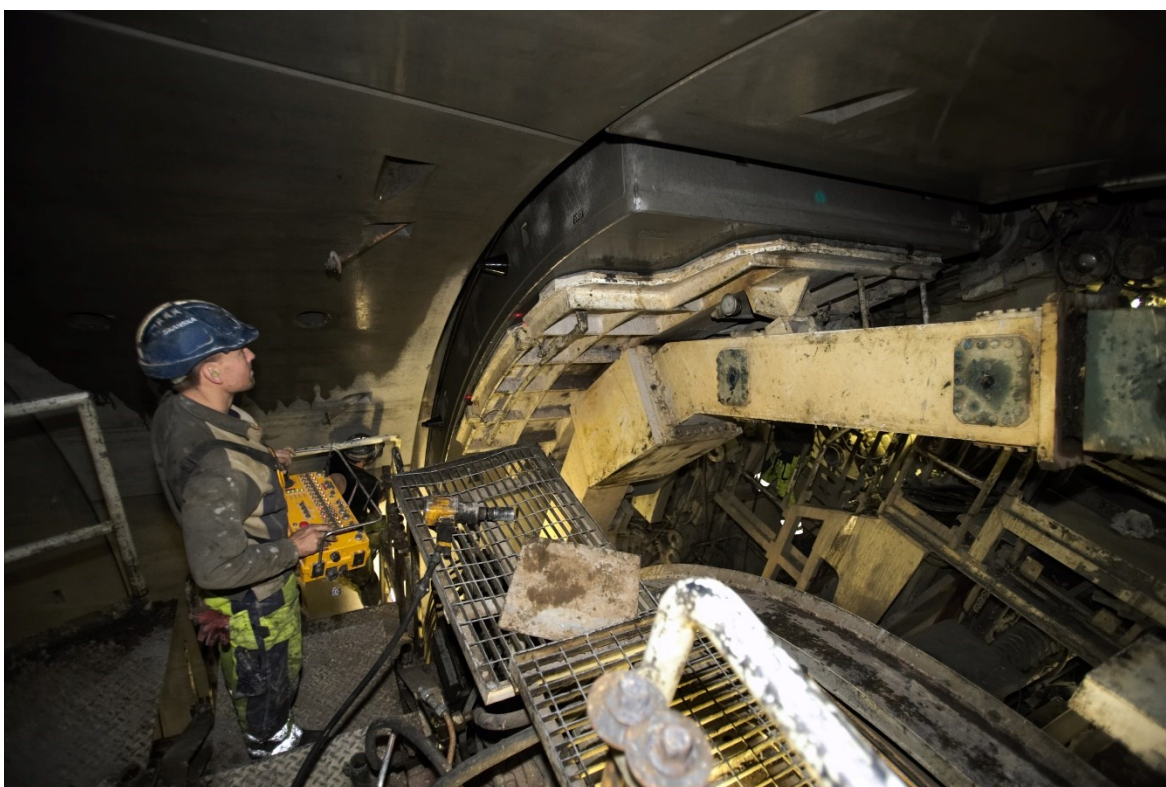
Bild 6. Montering av betongsegmenten i Hallandsås tunneln. Trafikverket 2015. Foto: Magnus Torle.
