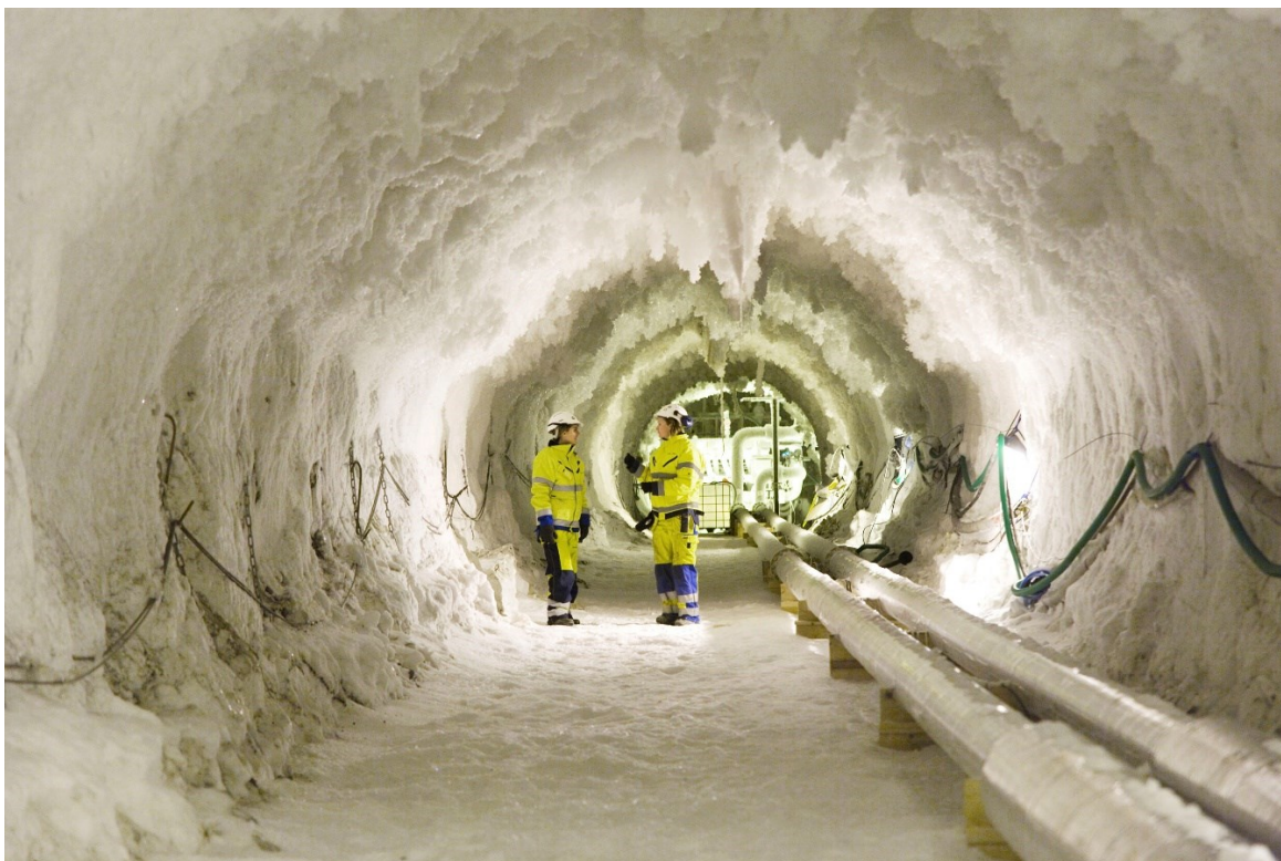
Bild 7. Frysning av Möllebackzonen. Trafikverket 2015. Foto: Holger Staffansson.
