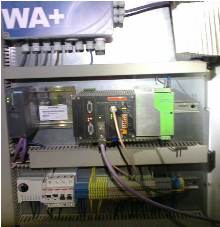
Kuva 11. CRK:n senkkavaunun WA-903+ vaakalaite käytössä.
