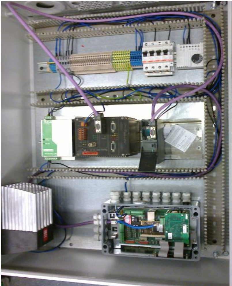
Kuva 10. WÄ-903+ asennuspaketti CRK:n senkkavaunuun.
