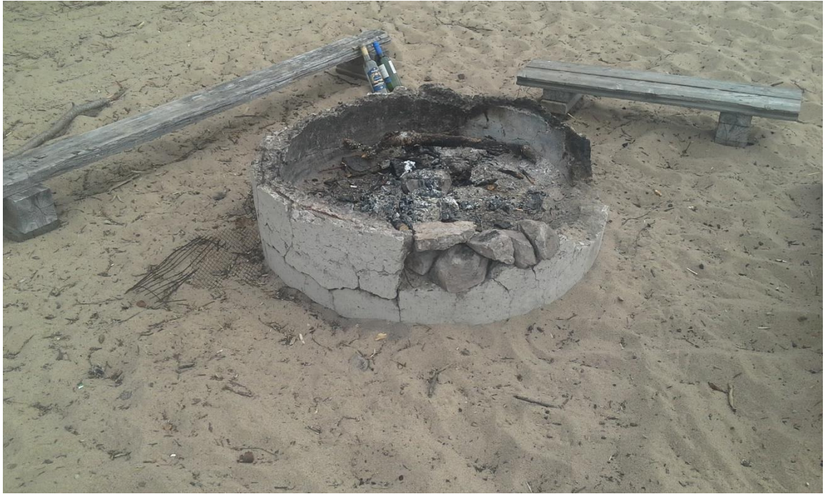
Kuva 35. Nykyiset makkaranpaistopaikat ovat liian lähellä rantaa. Betonirenkaat murenevat palasiksi jään liikkumisen vuoksi.
