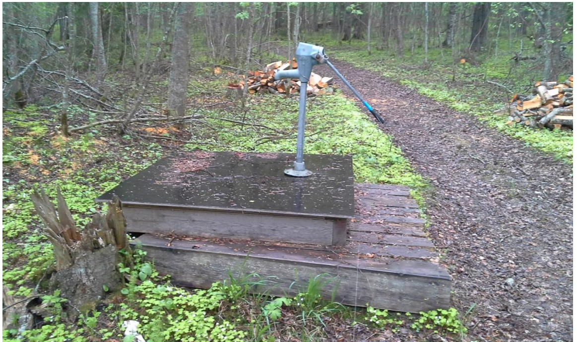
Kuva 11. Ärjänsaaren betonirengaskaivo, varustettuna on imupumpulla.
