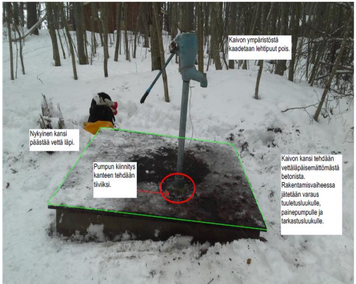
Kuva 12. Ärjänsaaren betonirengaskaivon näkyviä parannuksia.
