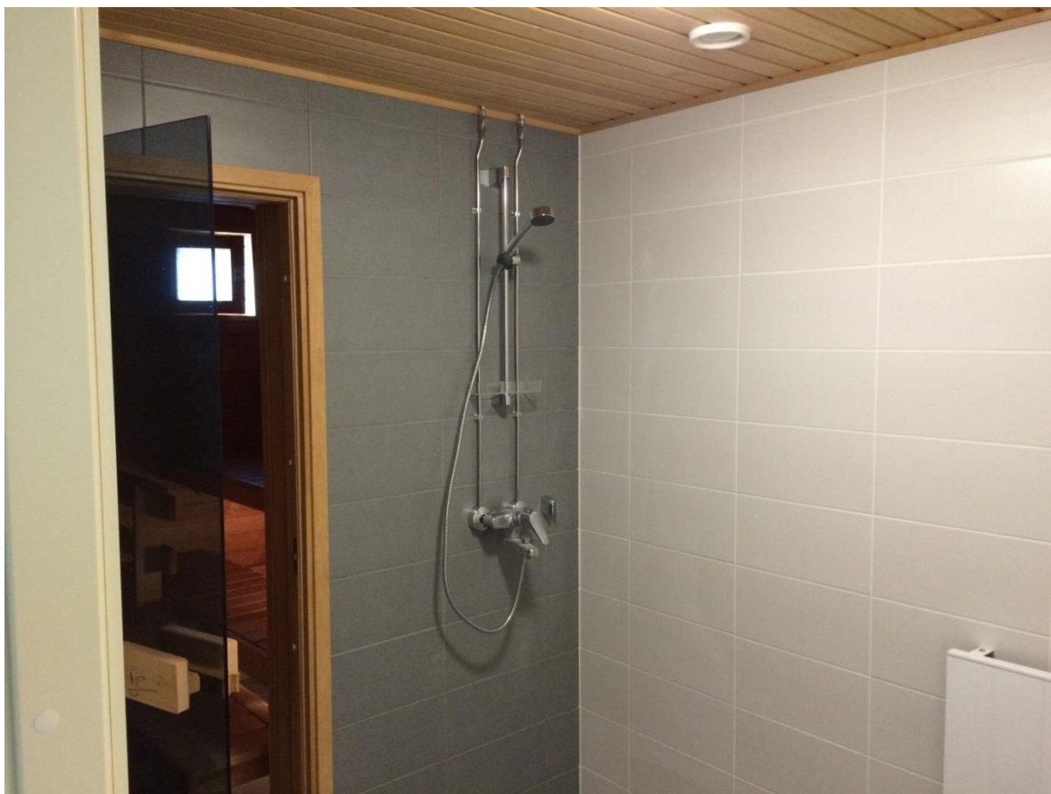
Kuva 3. Laatuvaatimukset täyttävä valmis kylpyhuone (Huhtilainen 2015)
