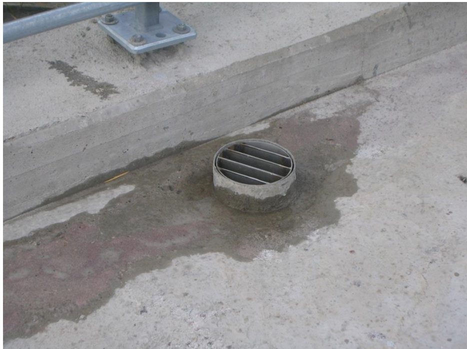
Kuva 1. Pintavesiputki ennen kannen eristämistä (Sillanrakennus oppimateriaali).
