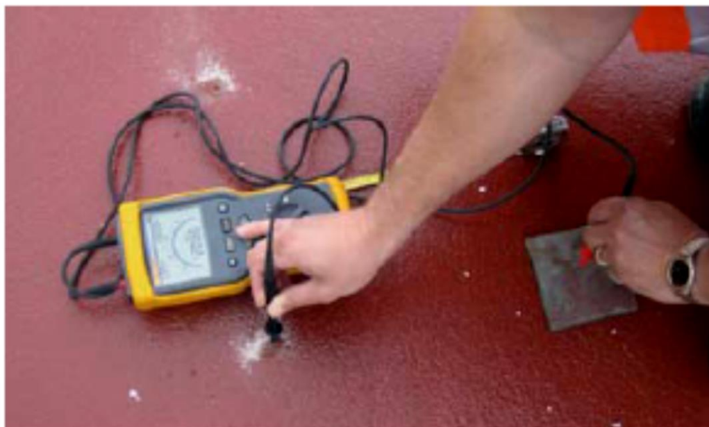
Kuva 12. Tiivistysepoksin eristysvastuksen mittaus matalajännitemenetelmällä VTT 2654. (Kuva: SILKO 1.801 Kannen pintarakenteet, vedeneristykset 04/11).
