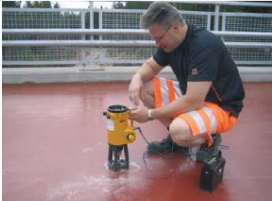
Kuva 11. Tiivistysepoxsin tartuntavetomittaus. (Kuva: SILKO 1.801 Kannen pintarakenteet, vedeneristykset 04/11)
