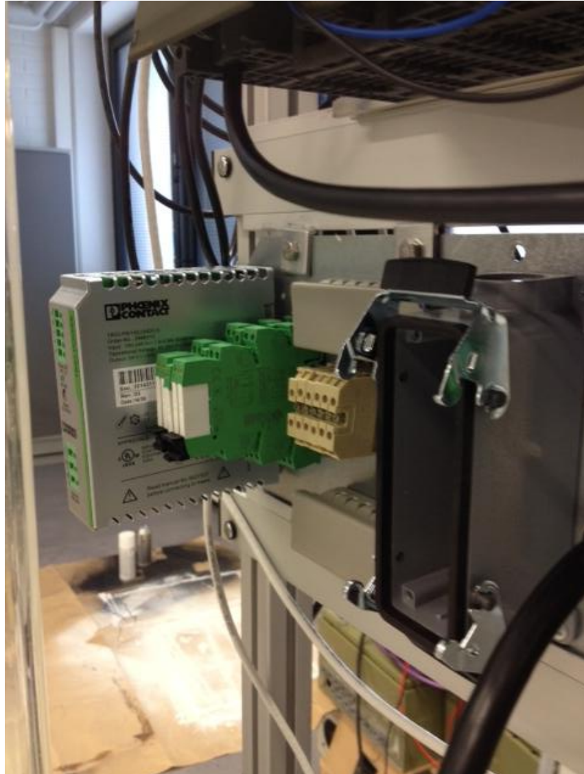
Kuva 9. Komponentteja asennettuna levyille
