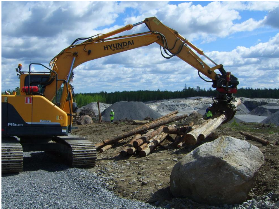
Kuva 9 Lahokon rakennuksessa käytettiin apuna kaivinkonetta raskaimpien runkojen siirtämiseen
