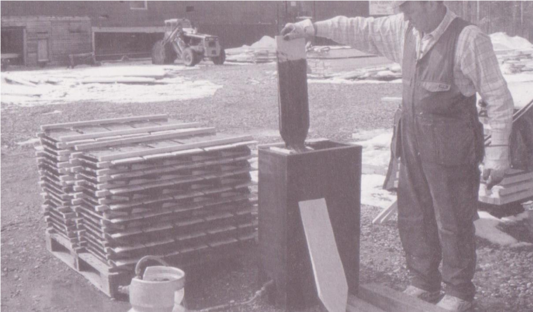
Kuva 19. Paanuja kastetaan tervassa, Sodankylän vanhan kirkon restaurointiprojektissa v. 1992–95 Lähde: Pihkala Antti, 2003, Suomalainen hautaterva, Rakennusperinteen Ystävät ry, s. 27
