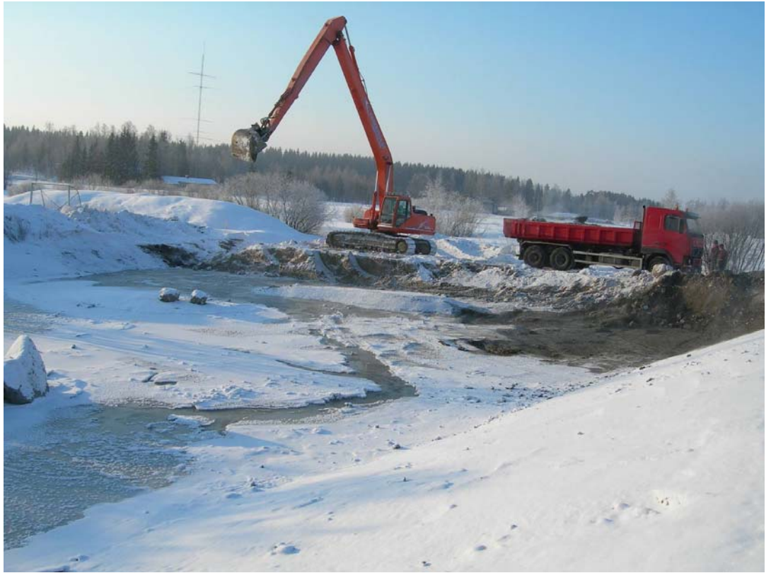
Kuva 4. Marjamäen hulevesialtaan kaivua vuonna 2006.(Lasse Sampakoski)
