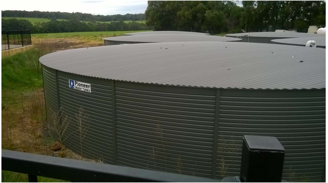
Kuva 21. Viinitarhan sadeveden varastosäiliötä Länsi-Australiasta. (Lasse Sampakoski)
