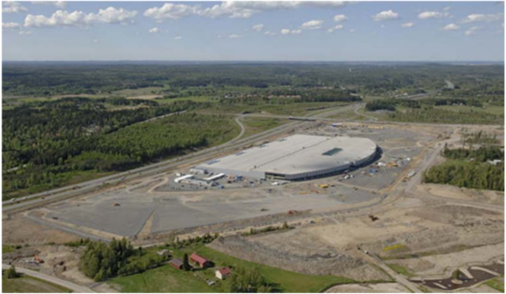
Kuva 6. Ideapark rakenteilla kesällä 2006.(Lasse Sampakoski)
