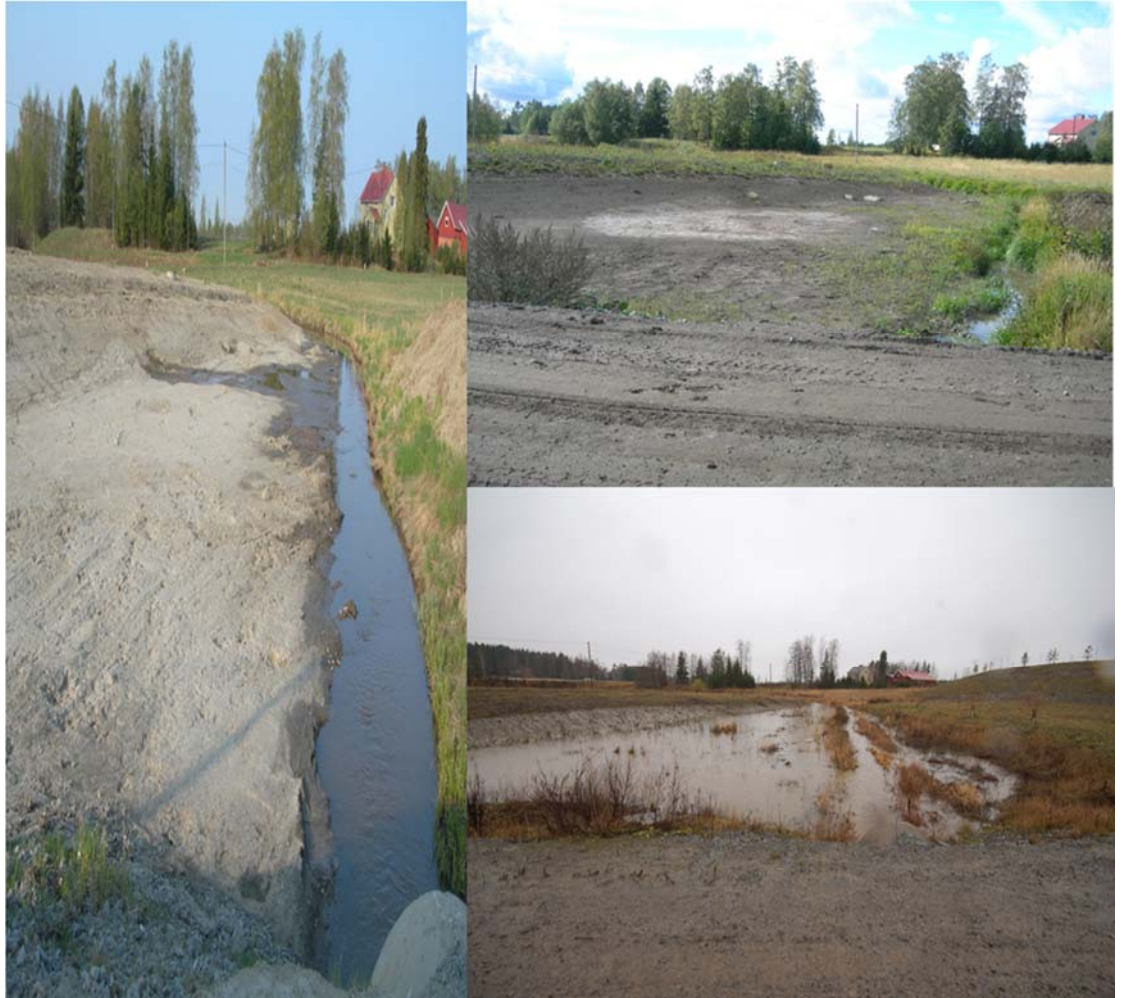
Kuva 8. Hulevesialtaan alapuolinen tulvatasanne. (Lasse Sampakoski)
