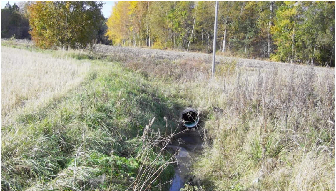
Kuva 9. OVA 2:n ja OVA 3:n purkukohta sekä Rantaniityntien alittava rumpu. Kuivankin ajanjakson aikana laajalla valuma-alueella muodostuu perusvaluntaa.
