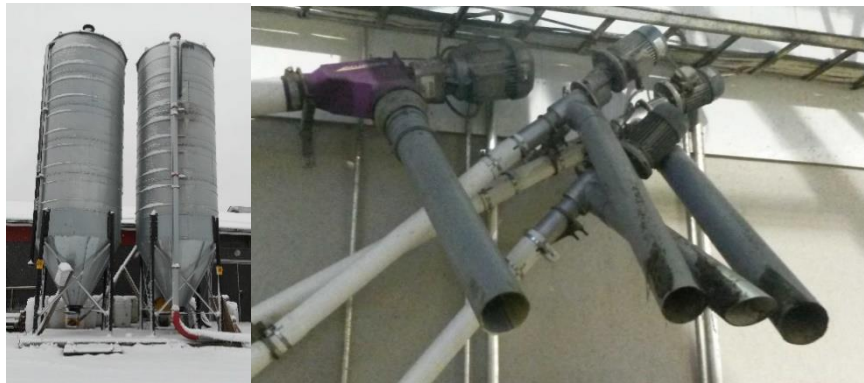
Kuva 13. Väkirehut voidaan annostella ruuvikuljettimilla siiloista suoraan sekoitus- ja ruokintarobottiin (Friman 2015).
