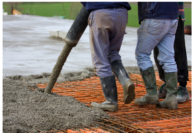
FIGUR 3. Platsgjutning av betong.
