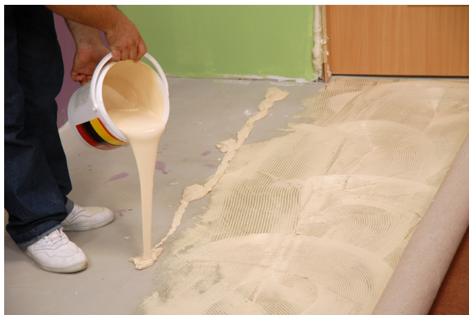
FIGUR 5. Limning av golvmatta.
