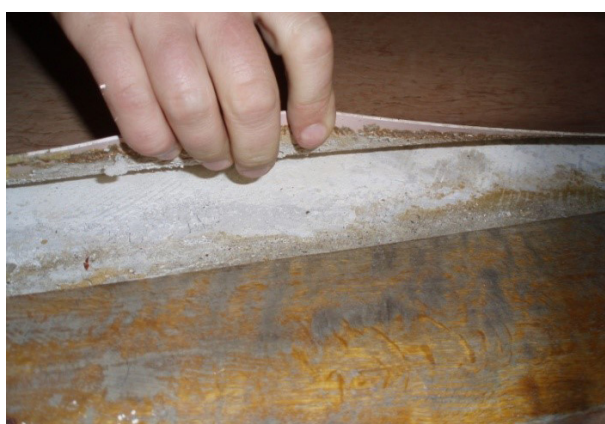
FIGUR 10. Sensoriska observationer är viktiga vid en skadeutredning.
