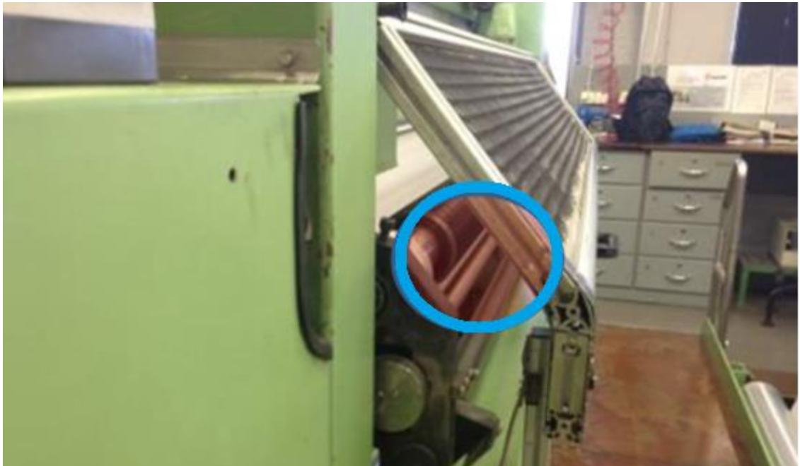
KUVA 7. Sininen soikio osoittaa pituusleikkurin teräsuojan puutteellisuutta (Kuva: Paperitehdas)
