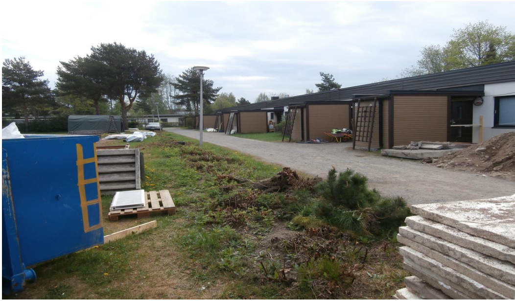
KUVA 10 esimerkkityömaa ( OMA KUVA )
