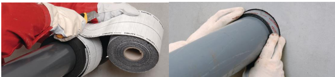
KUVA 6 palossa paisuvat putki ja saumanauhhat ( HILTI OY )
