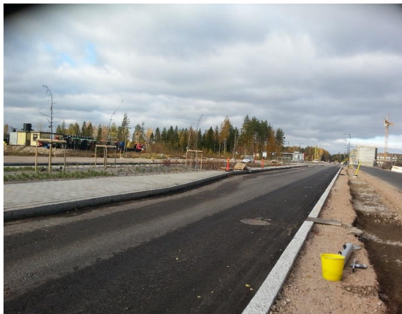
Kuva 7. Rakennuskohde. Kivistö, Vanha Nurmijärventie.
