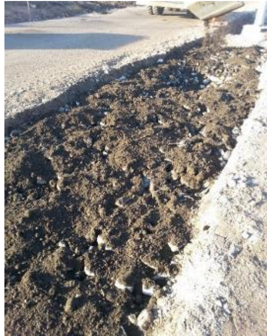
Kuva 13. Kasvualustakerros levitettyinä ja tasoitettuna.
