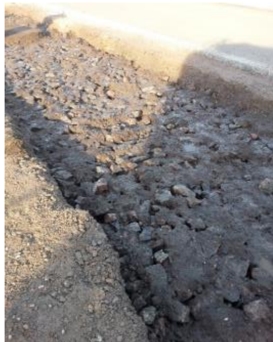
Kuva 15. Tiivistetty valmis kantava kasvualustakerros.
