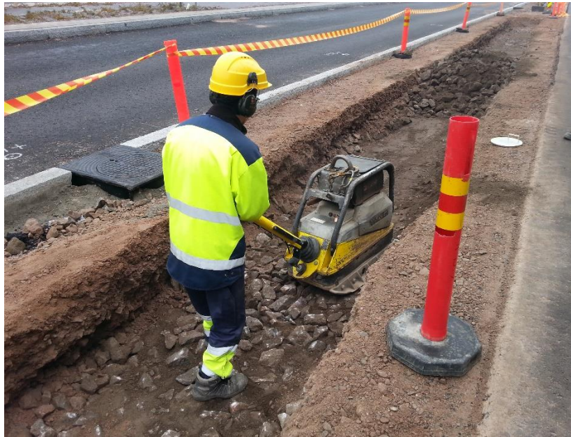
Kuva 10. Tärylevyllä tiivistäminen.
