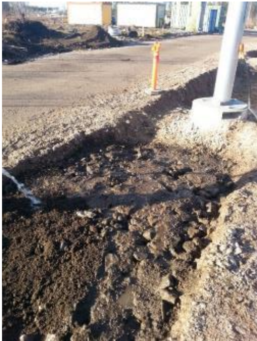
Kuva 14. Kasvualustan valuttamista louheen väleihin veden avulla.
