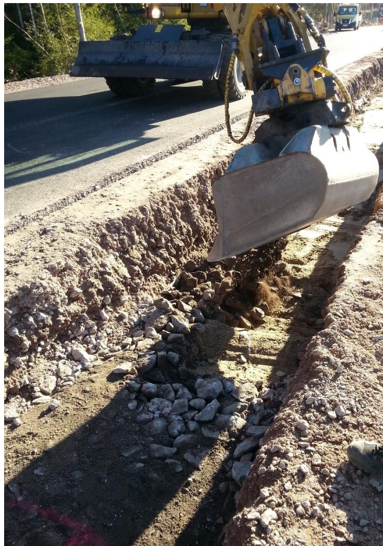
Kuva 9. Kantavan kasvualustamassan levitys.
