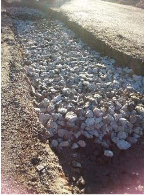
Kuva 12. Kantava louhekerros levitettyinä.
