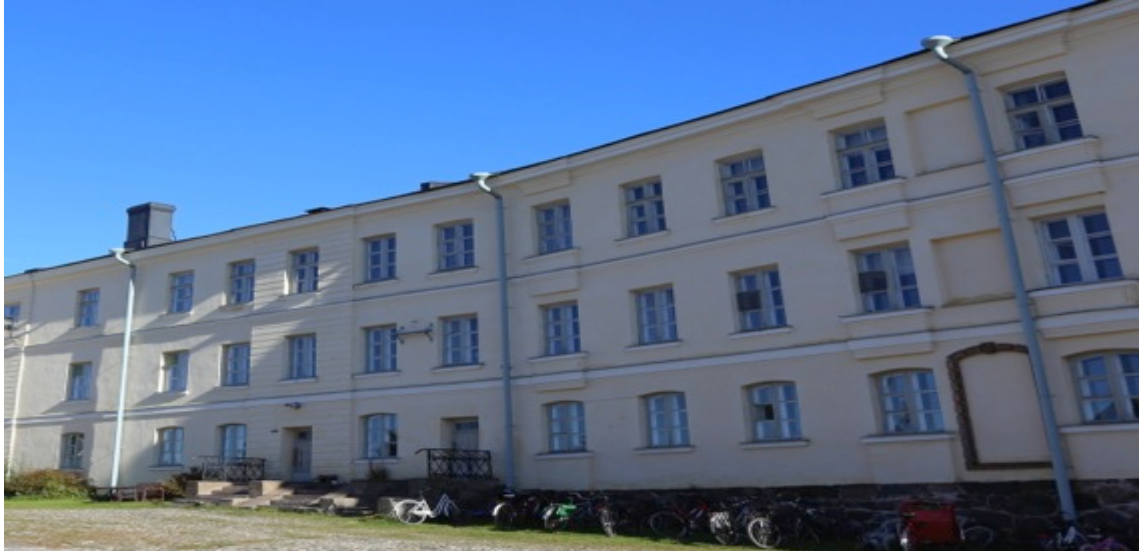
Kuva 1. Kustavilaisen ajan rapattua julkisivua Suomenlinnassa.
