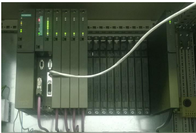
Kuva 10. S7-400 -sarjan 18-paikkainen keskuskehikko, johon on liitetty virtalähde, keskusyksikkö, kommunikointimoduuleja sekä liitännämoduuli (Heinonen, 2015)
