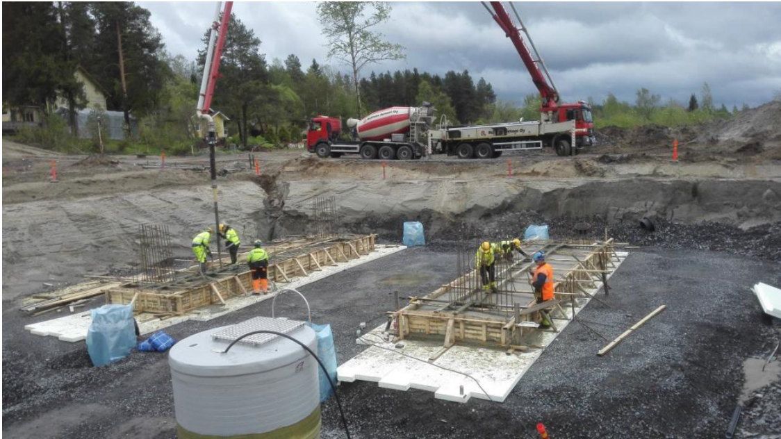
KUVA 10. Sillan peruslaattojen betonointi
