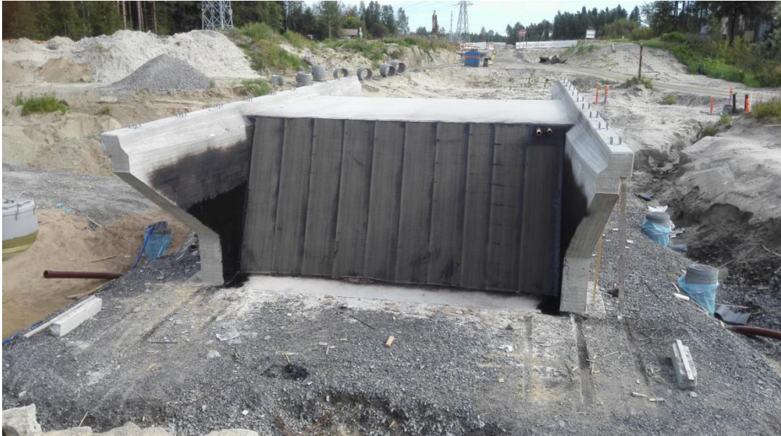
KUVA 14. Sillan kehäjalkojen ja siipimuurien eristystä
