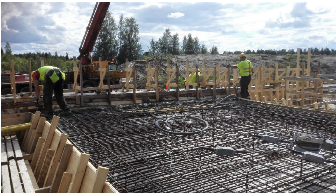
KUVA 12. Sillan kehän, siipimuurien ja reunapalkkien betonointi
