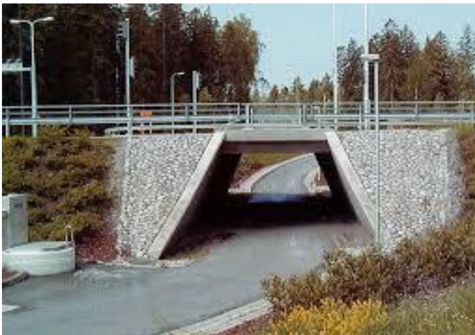
KUVA 2. Teräsbetonien vinojalkainen laattakehäsilta (3, s.1)
