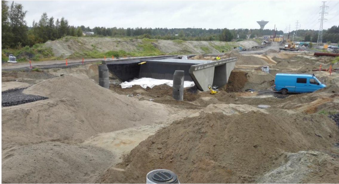
KUVA 15. Sillan ympäristäyttyöt ja kuivatusten rakentaminen
