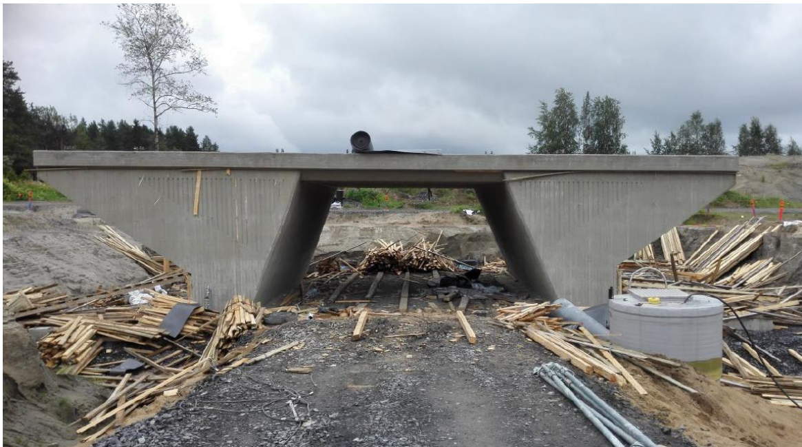
KUVA 13. Silta muottien purkamisen jälkeen
