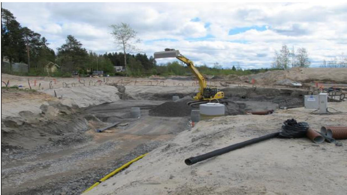
KUVA 9. Sillan perustusten rakentaminen
