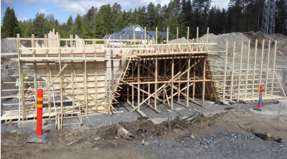
KUVA 11. Sillan kehän, siipimuurien ja reunapalkkien muotteja sekä telineitä
