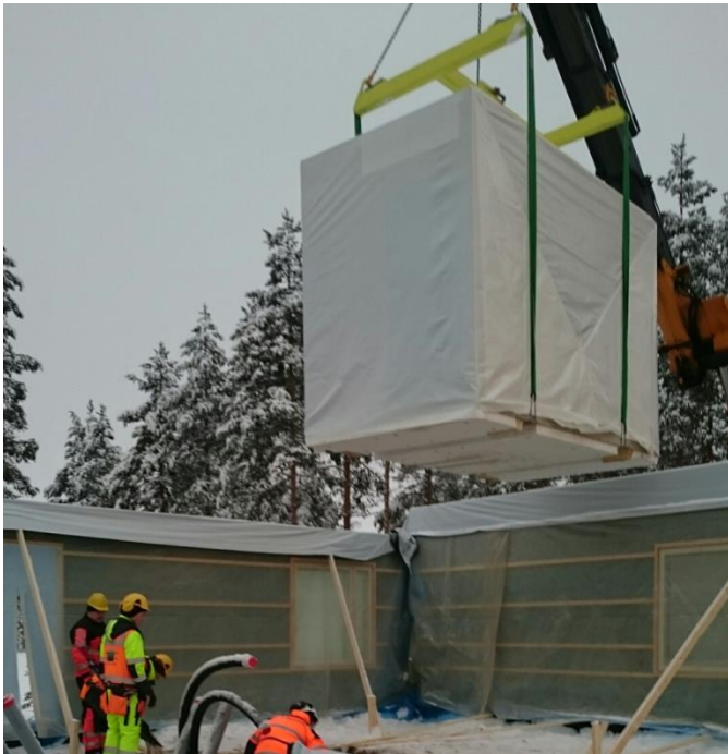
KUVA 17. Moduulien nostamiseen käytetty nostolaite Esperi Care Kuusamo -kohteessa
