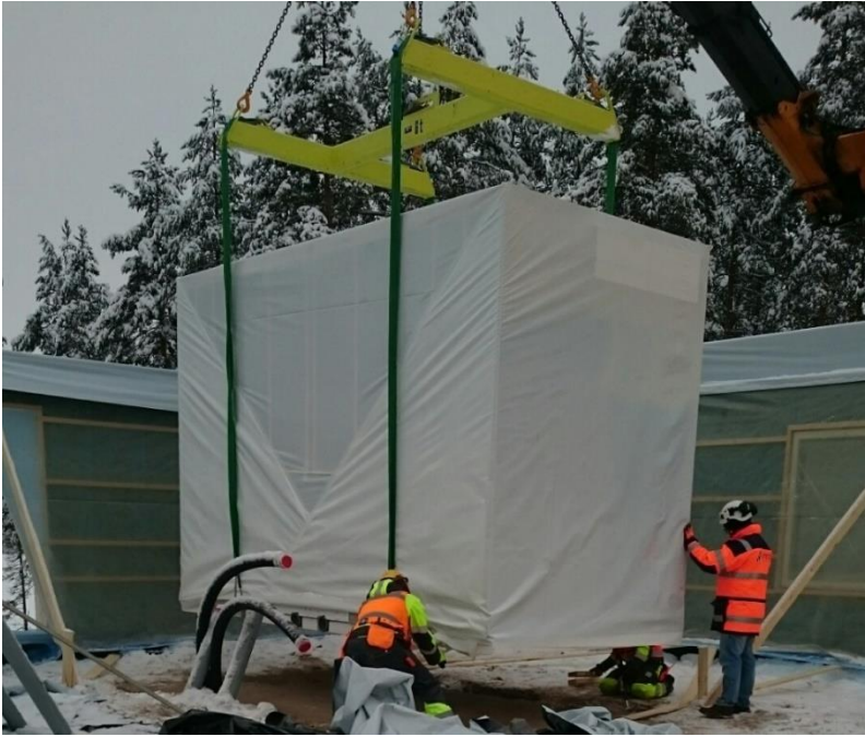
KUVA 19. Moduulin asentamista Esperi Care Kuusamo -kohteessa
