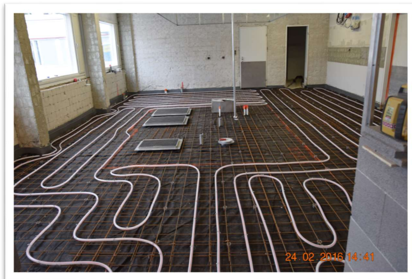
Kuva 59. Keittiön lattialämmityspiirit.
