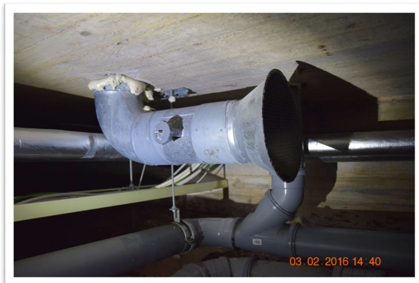
Kuva 33. 1. kerroksen ilmanvaihdonsuunnitelmissa näkyy A- ja B-siiven alapohjaa palvelevan kanavapuhaltimen (PF1) sijainti.
