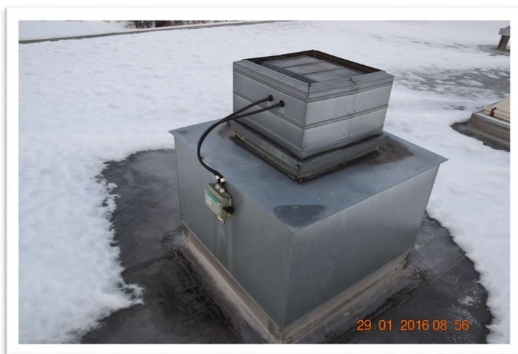
Kuva 38. Vesikatolla on huippuimureita usealta eri vuosikymmeneltä, kuvassa oleva huippuimuri on uusinta mallia 90-luvulta.
