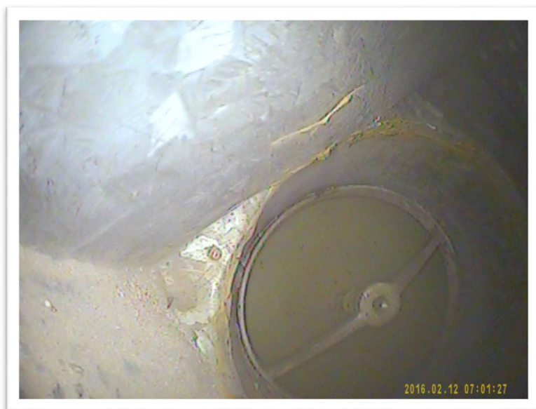
Kuva 36. C-siiven kellarista kuvattu kanava, joka ylittää nuohoukselle asetetun P2:n rajan.
