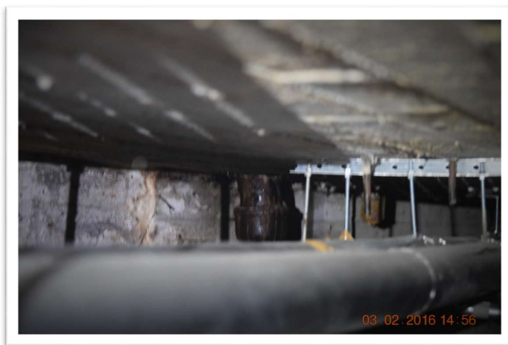
Kuva 19. Takana näkyvä sadevesiviemäri on alkuperäinen 1960-luvulta.
