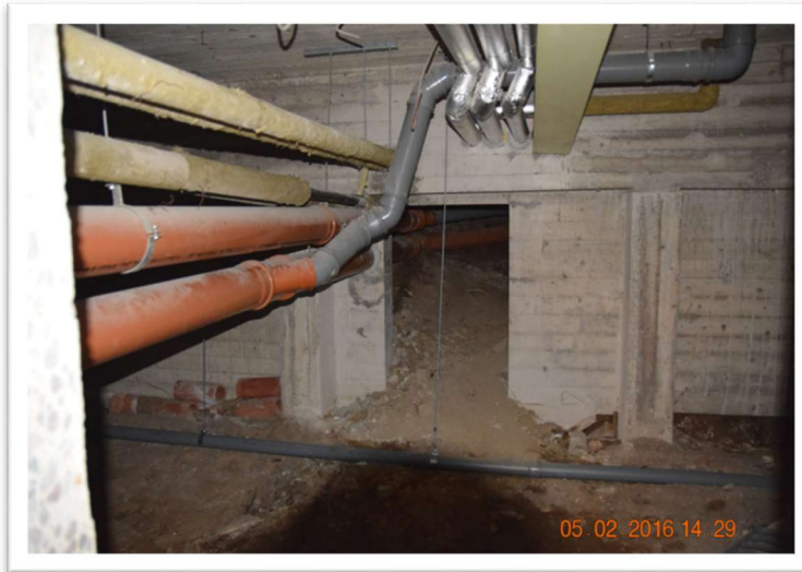
Kuva 12. Kuvassa on A- ja B-siiven alapohjaan johtava kulkuaukko.
