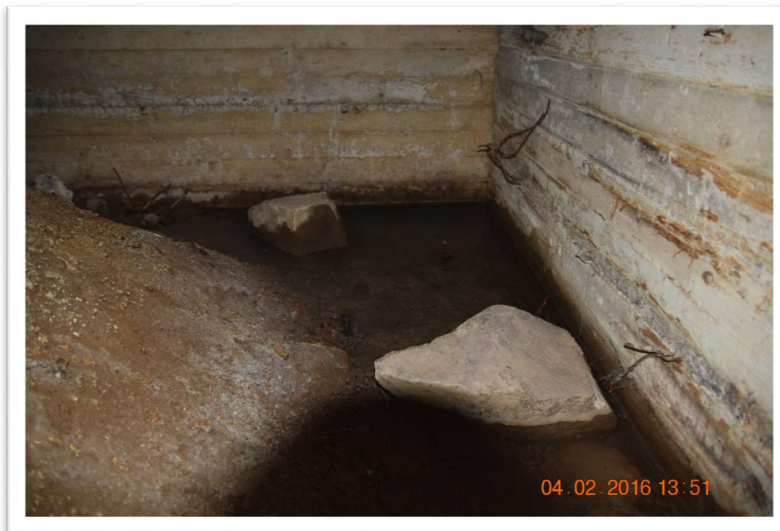
Kuva 44. Kuva on otettu D-siiven alapohjasta, jonne hulevesi useasti kerääntyy.
