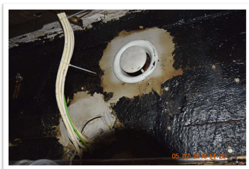
Kuva 37. D-siiven putkikäytävän korvausilma johdetaan lautasventtiiliin kautta.
