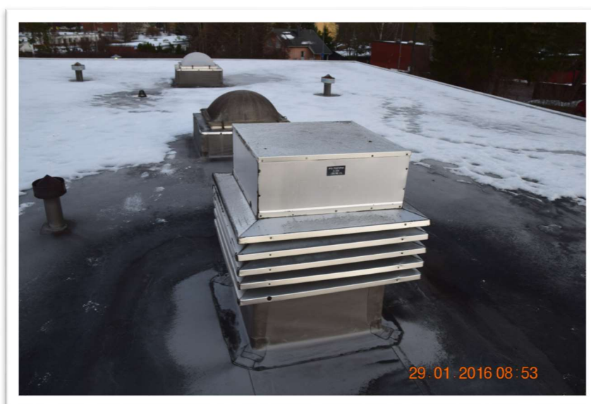
Kuva 41. D-siipeä palveleva alkuperäinen huippumuri.
