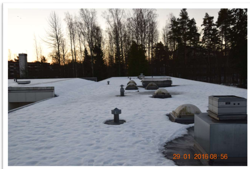
Kuva 1. Näkymä A-siiven vesikatolta.
