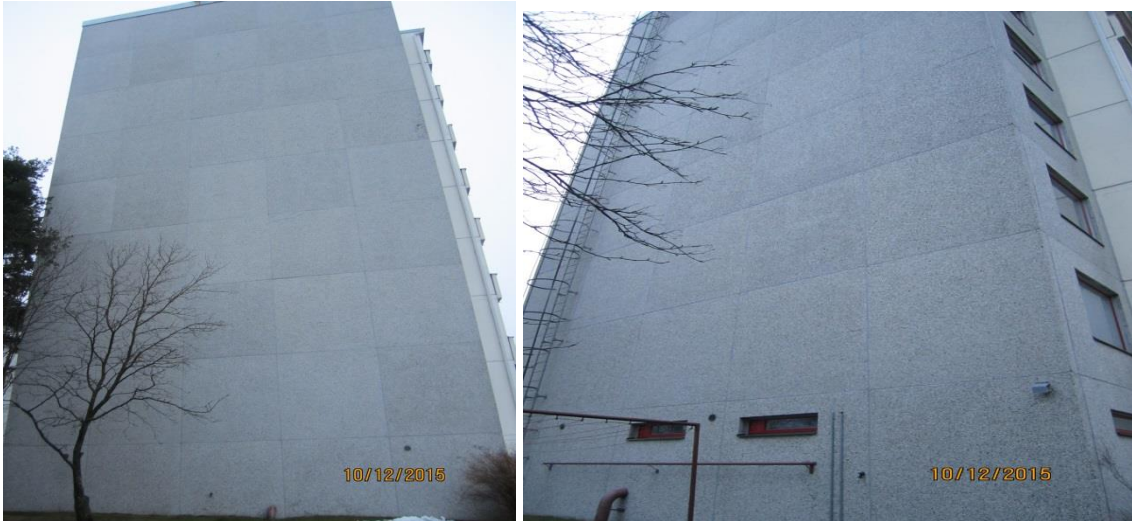
KUVA 5. Vuonna 1977 valmistuneen asuinkerrostalon päädyt, joissa on suuri pinta-ala eristettävää
