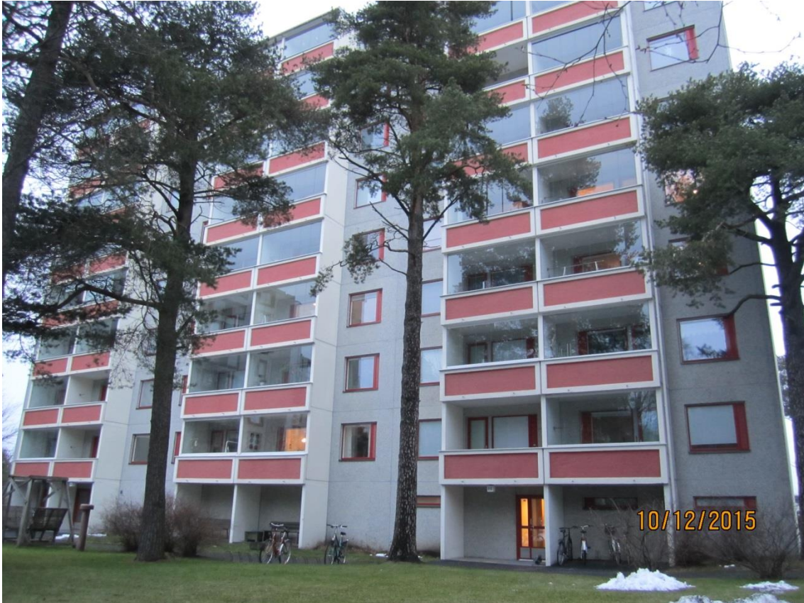
KUVA 4. Vuonna 1977 valmistuneen asuinkerrostalon parvekkeet, jotka ovat lasitetut
