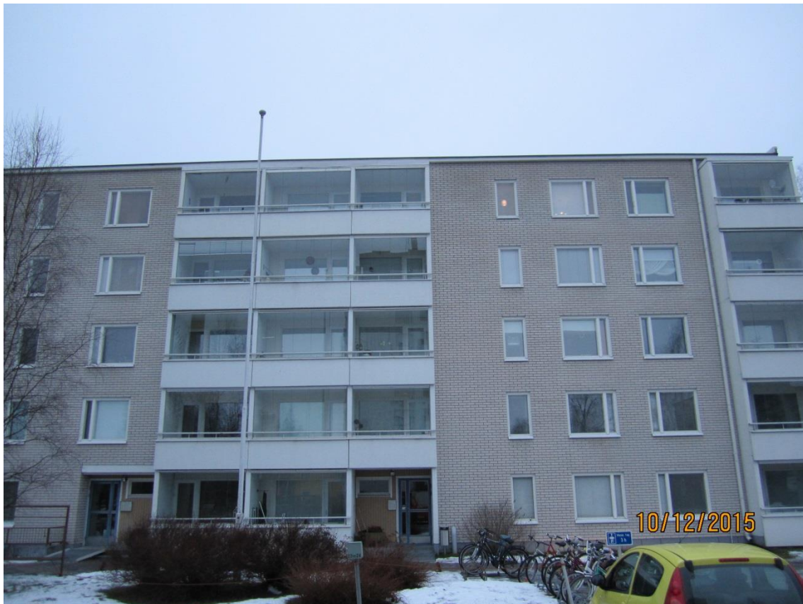
KUVA 1. Vuonna 1974 valmistuneen asuinkerrostalon kalkki-hiekka-tiiliverhoiltu julkisivu
