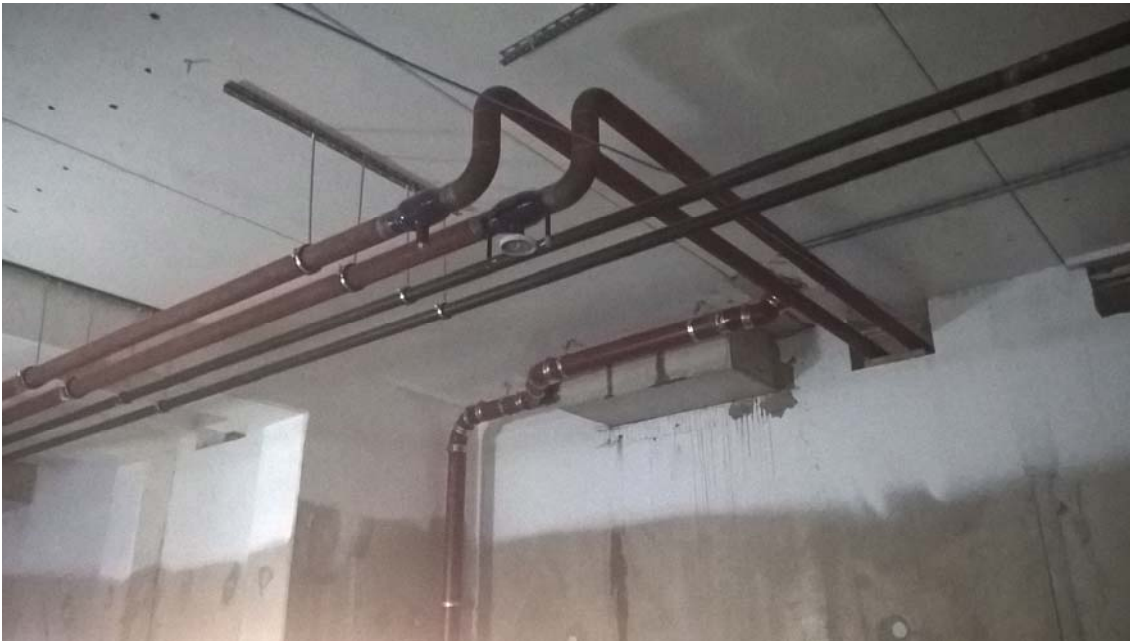
Kuva 7. Työssäoppijan hitsauksia työssäoppimispaikassa.
