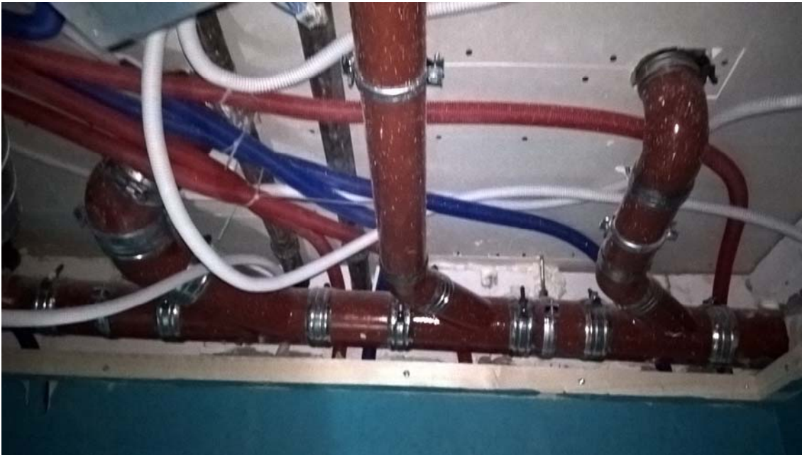
Kuva 8. Työssäoppijan käyttövesi- viemärijärjestelmien asennus alakatossa.
