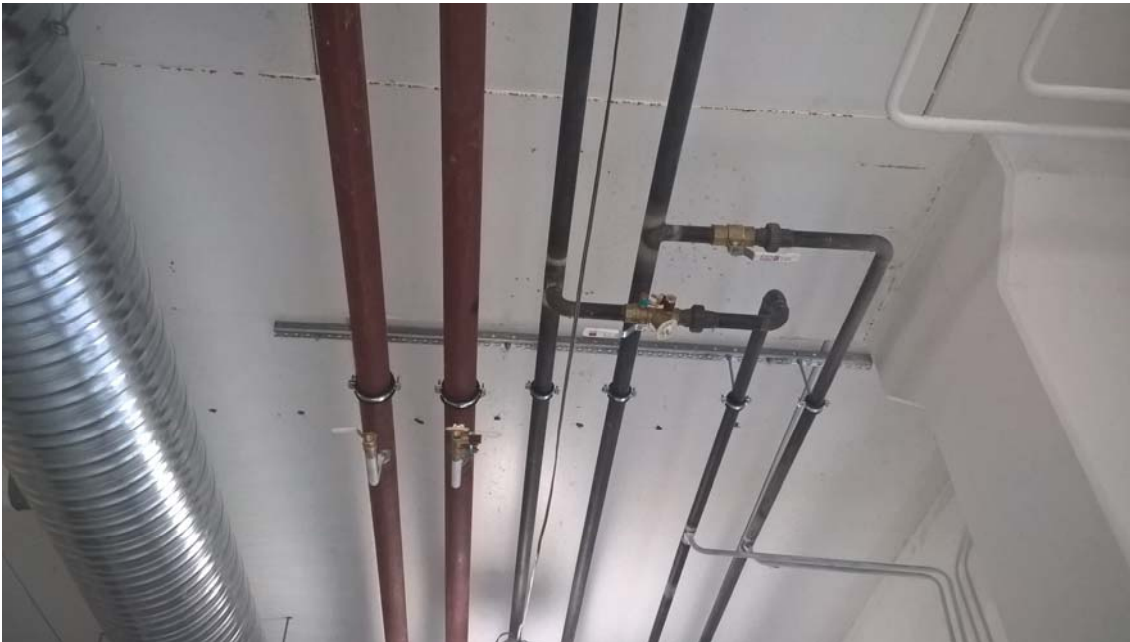
Kuva 10. Työssäoppijan asentama lämmitysjärjestelmä odottaa mittausta ja tasapainotusta.
