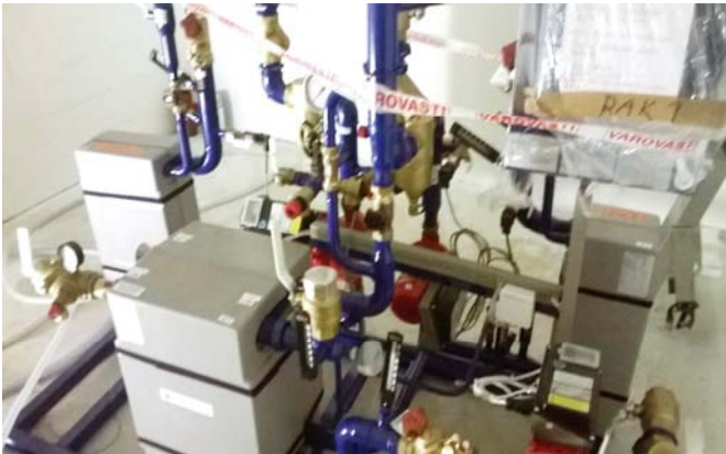
Kuva 1. Keskus paikoillaan lämmönjakohuoneessa.
