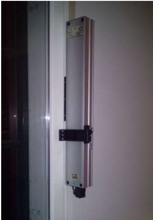
Bild 2 (ovan). Anordning för aktivering av rökventilation och avstängning av den normala ventilationen. Foto: Niklas Öhman
