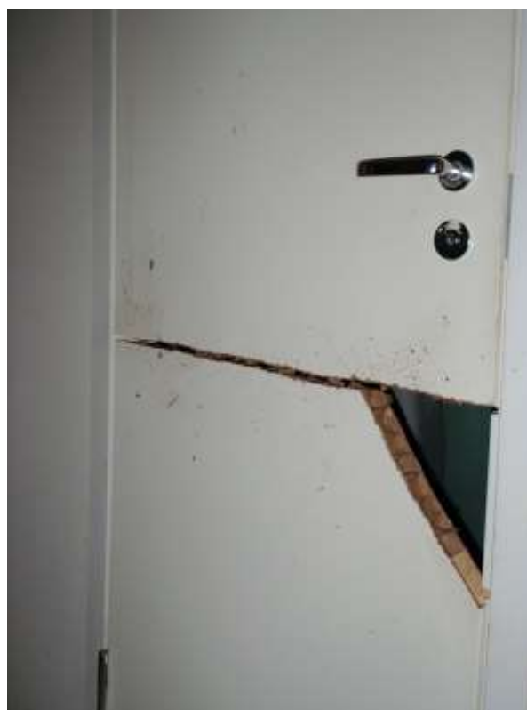
Bild 8. Dörr uppsågad med lucka för slang. Foto:LUP
