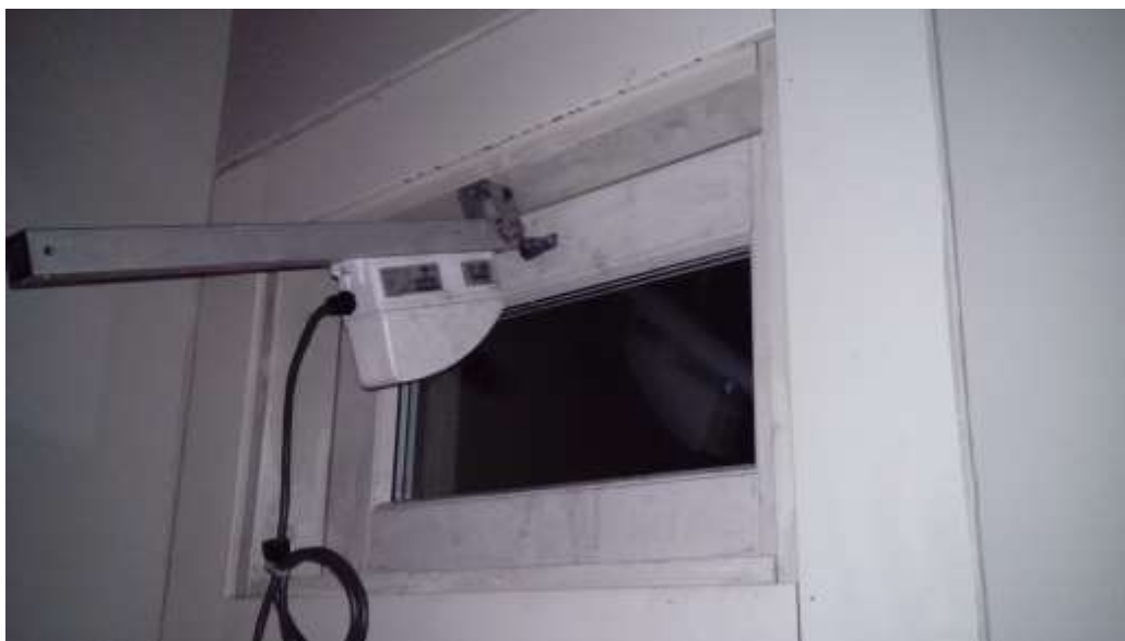
Bild 5. Fönster försett med gängstångsöppnare. Foto: Niklas Öhman
