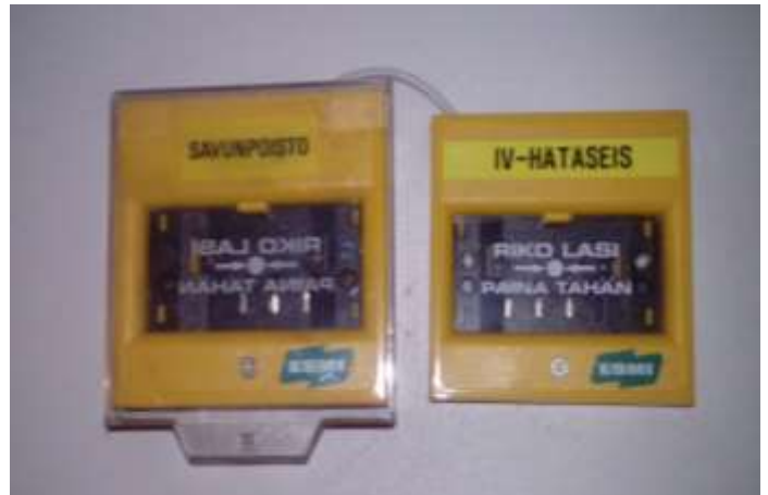
Bild 2 (ovan). Anordning för aktivering av rökventilation och avstängning av den normala ventilationen. Foto: Niklas Öhman
