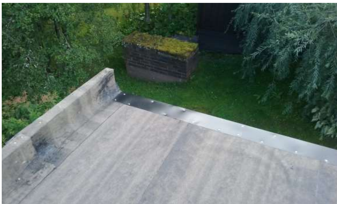
Kuva 17. Aluskermi asennettuna ja räystäspellit kiinnitettyinä.
