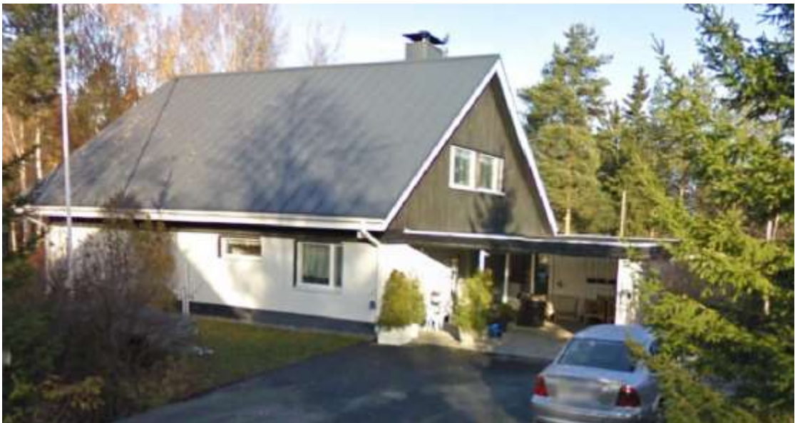
Kuva 1. Kohteen julkisivu kadun suunnasta.
