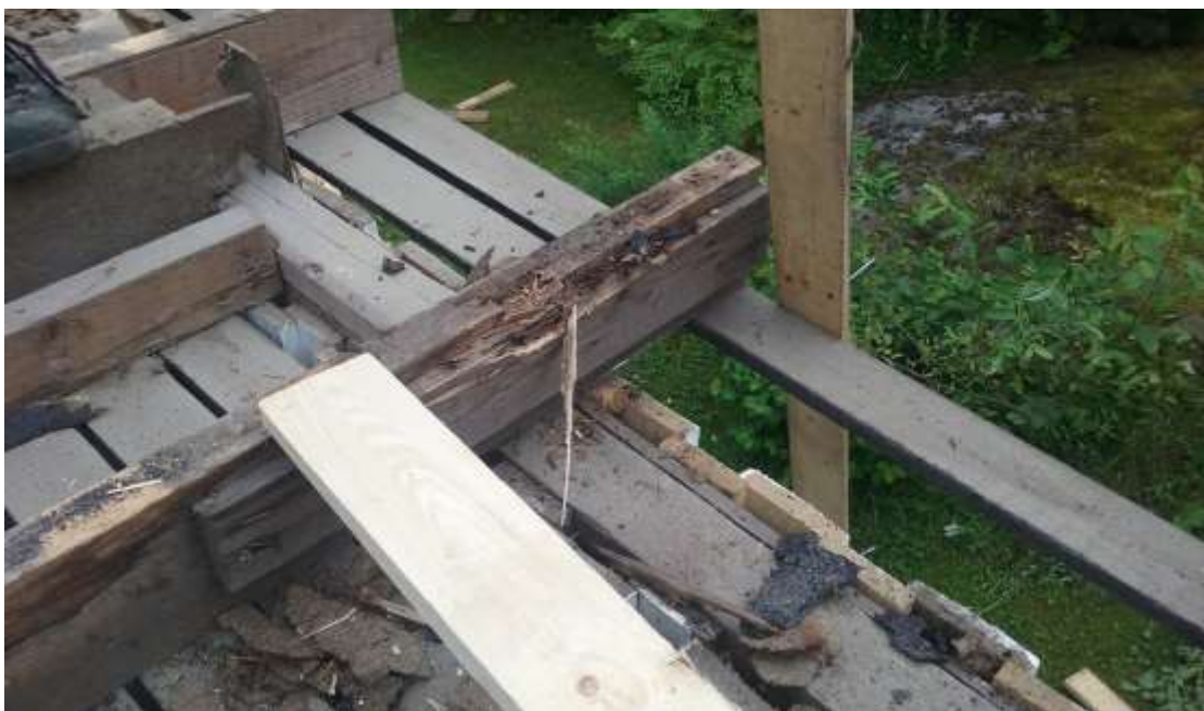
Kuva 9. Vanhan kattokaivon paikka.
