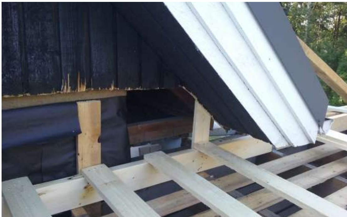
Kuva 12. Uuden kattorakenteen liittyminen talon räystääseen.
