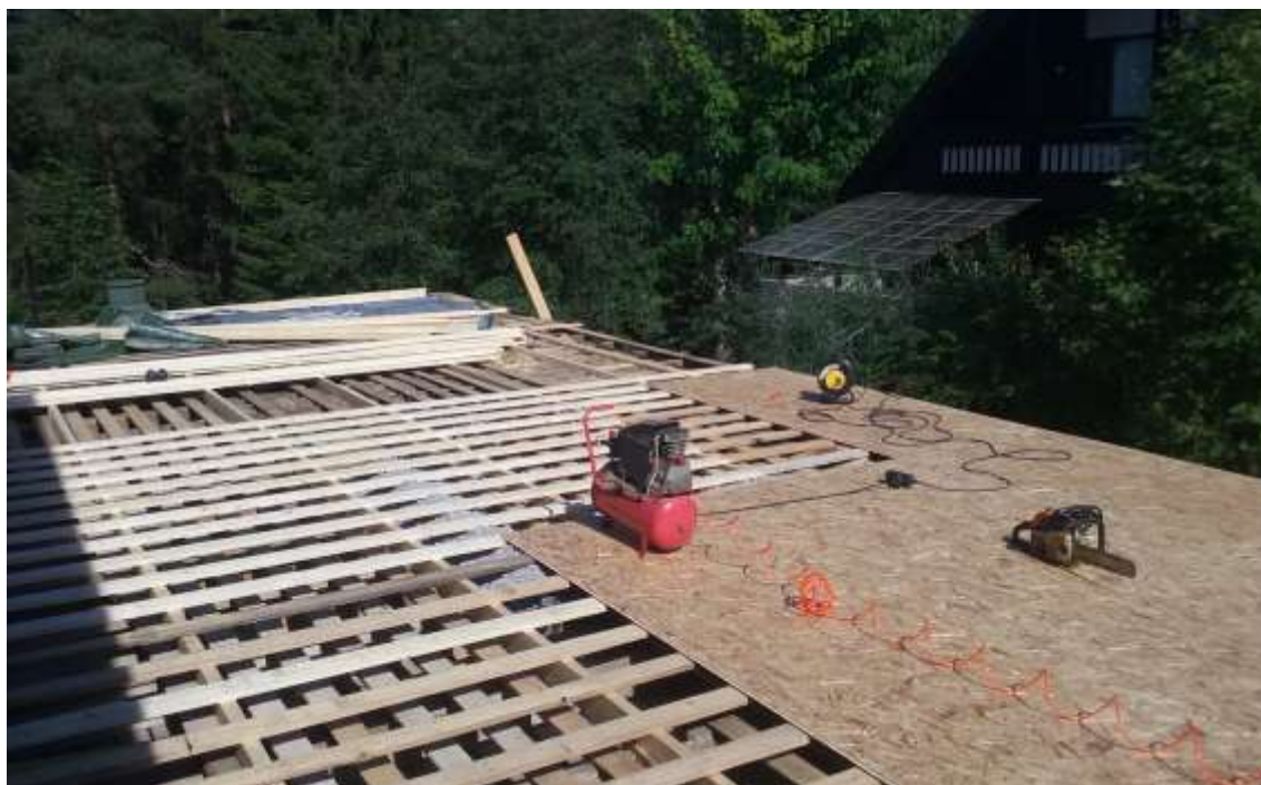
Kuva 15. Katon laudoittamista ja levyttämistä.
