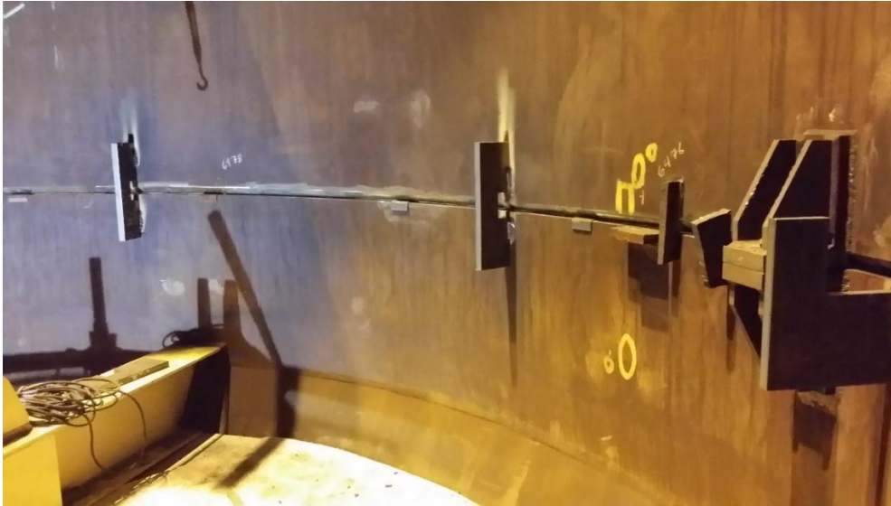
Kuva 10. Hitsaussauma kohdistuksen jälkeen.
