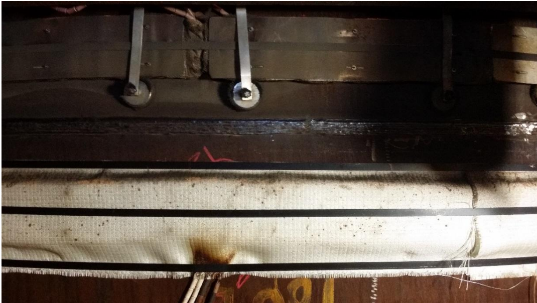
Kuva 13. Lämpövastukset hitsauksen aikana.
