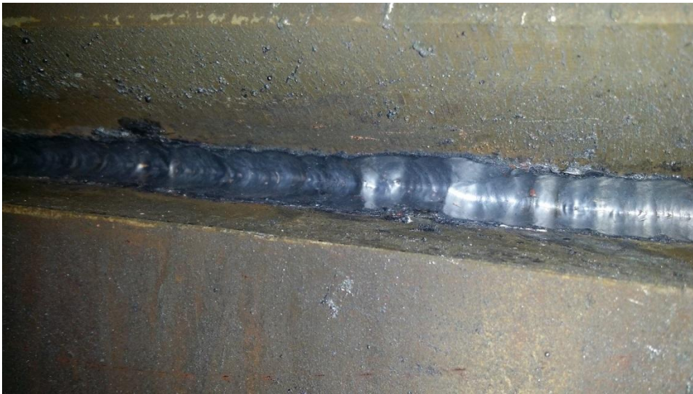
Kuva 8. Hitsin juuri aukaistu hiilikaaritaltaamalla.
