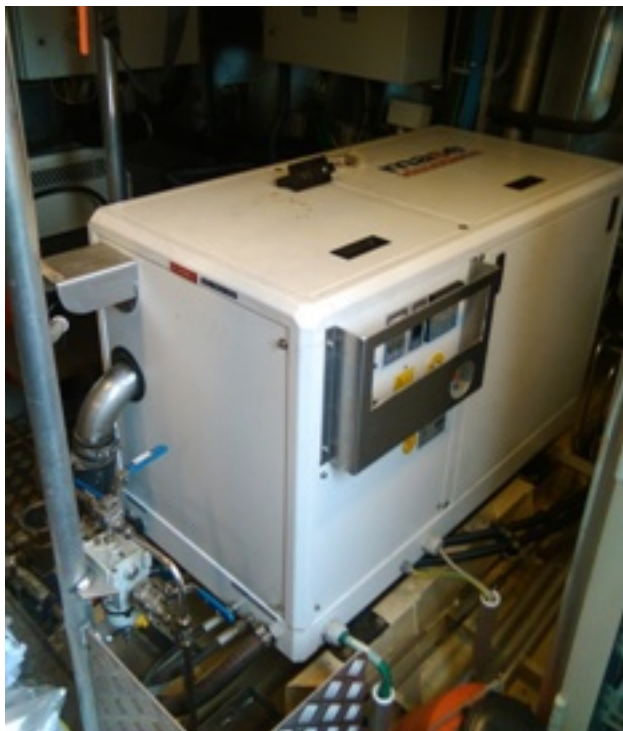
Kuva 14. Apukone Yanmar 4TNV98-GGE+Mase IS 30 generaattori. (Juho Tikka 2015)
