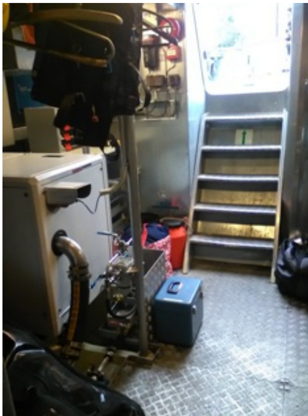
Kuva 26. Apulaitetila kuvattuna konehuoneesta. Isomman apukoneen viemä lisätila veisi merkittävän osan jo valmiiksi ahtaasta kulkuväylästä konehuoneeseen. (Juho Tikka 2016)
