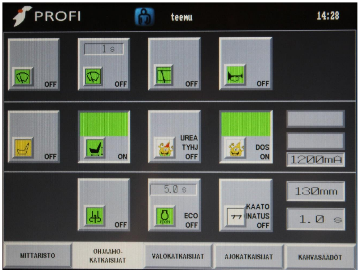
Kuva 3. Laitekytkimet-napilla avautuva ohjaamokatkaisijat näkymä”
