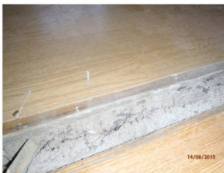
Väliseinän alajuoksun alle tulee asentaa solumuovi
