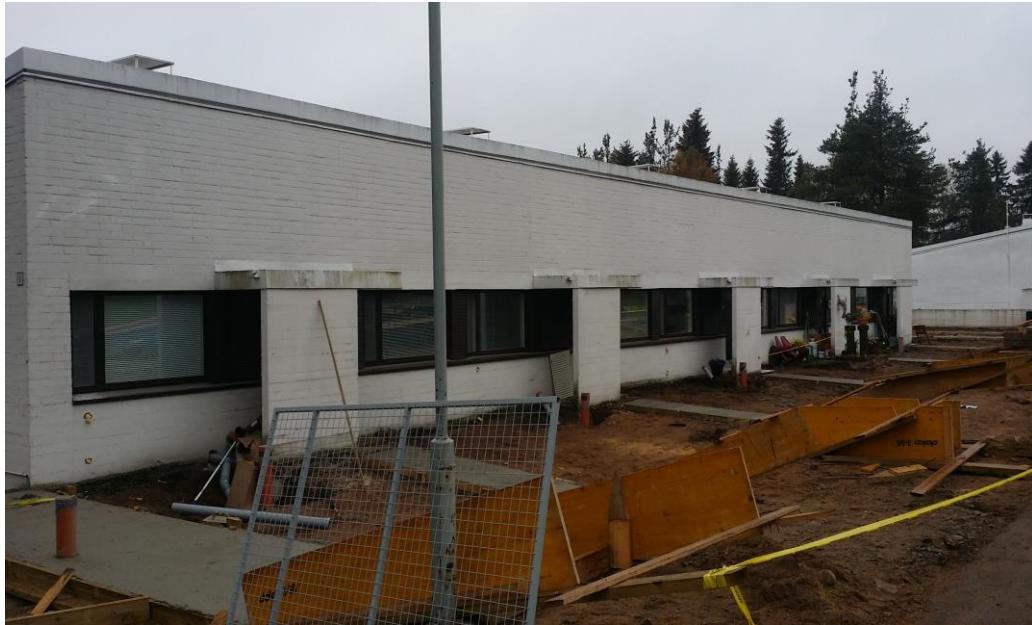
Kuva 2. Rakennus I:n julkisivu
