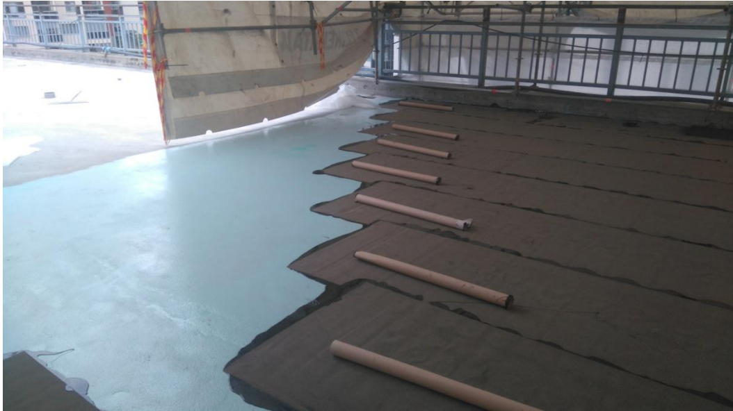
Kuva 21. Pohjakermin limitykset ja jatkoskohtien porrastus.
