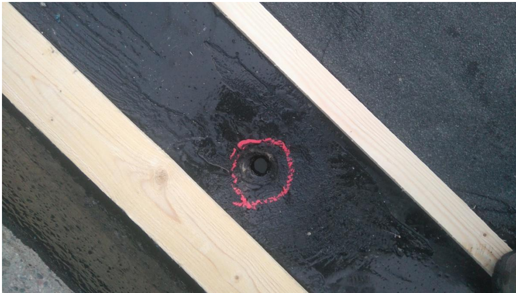
Kuva 22. Vedeneristys pintavesiputken päälle ulotettuna.
