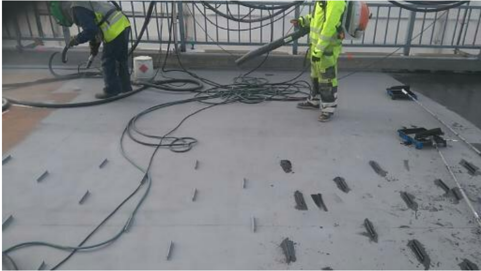
Kuva 17. Teräspinta korroosiosuojataan esimerkiksi bitumiliuoksella heti hiekkapuhalluksen perässä.
