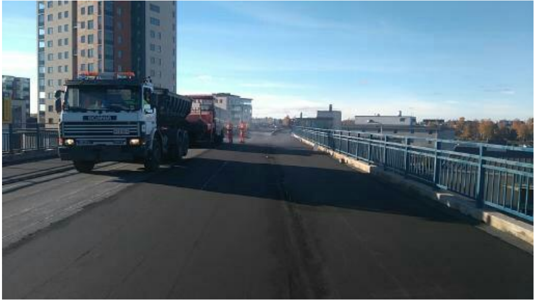
Kuva 24. Suoja-asfaltin levitys kermieristyksen päälle.
