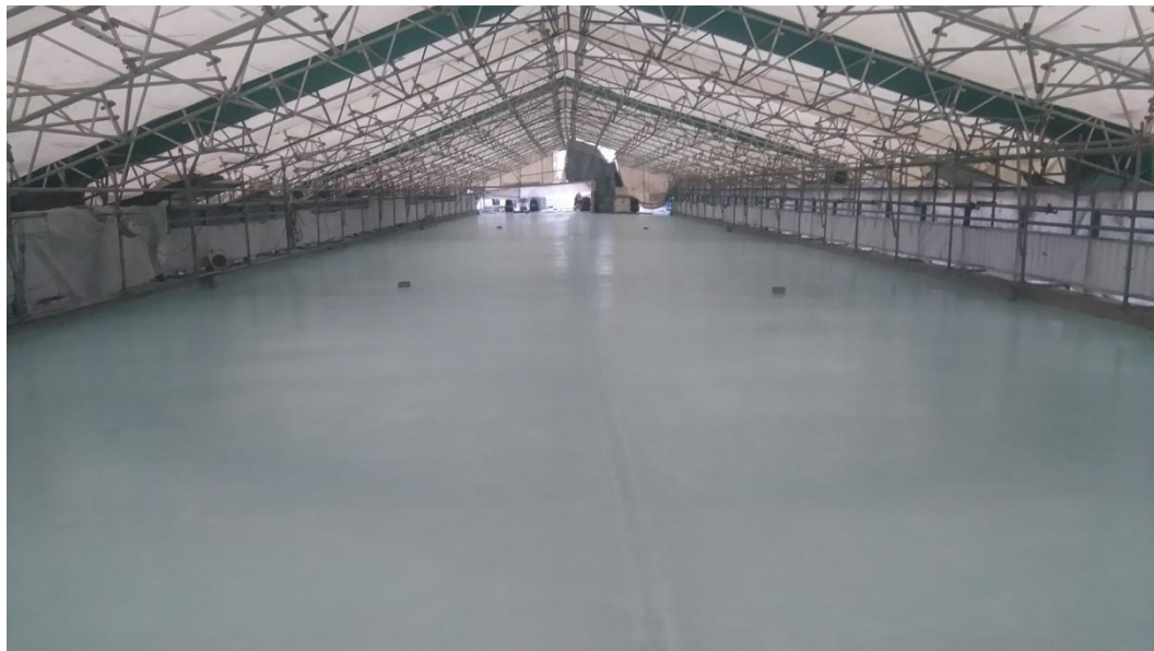
Kuva 18. Epoksiivistitys suoritetaan sääsuojan alla.
