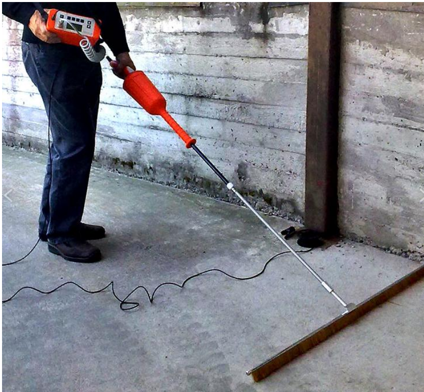
Kuva 20. Kipinäharava mittaus. (Kuva: YTM-Industrial Oy, Elcometer 266)
