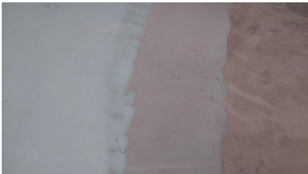
Kuva 19. Epoksiivistitys suoritetaan kahtena kerroksena.
