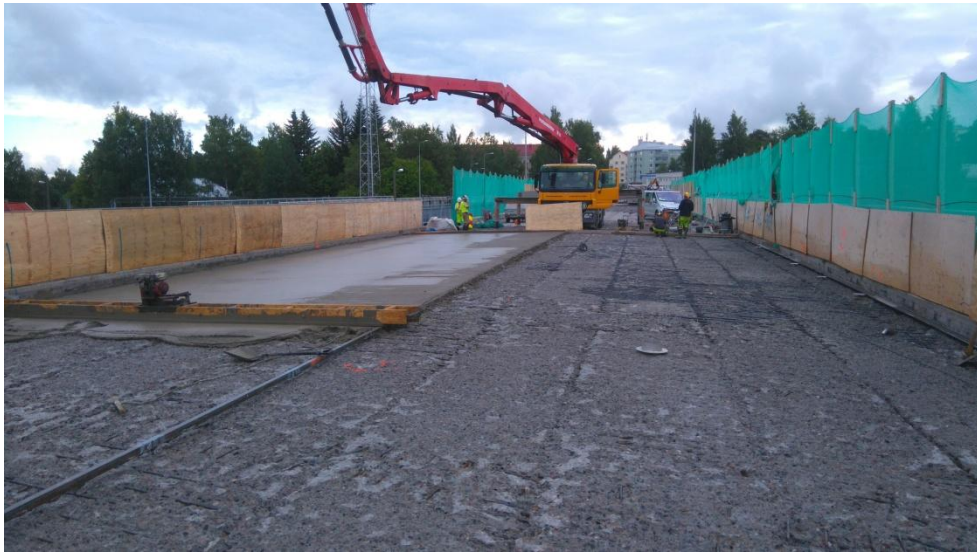
Kuva 13. Muotoiluvalun levittäminen tärypalkilla.
