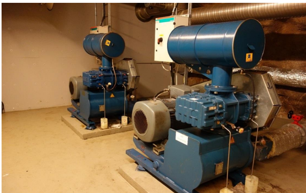
Figur 9 Två av tre blåsmaskiner, luft/vatten-värmeväxlaren är planerad att möjligen installeras på den bortre blåsmaskinen.
