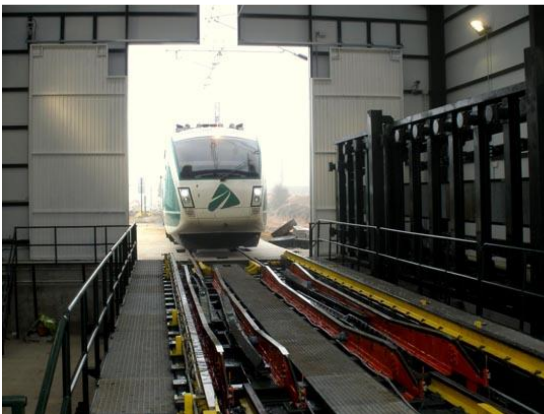
Kuva 4: Raidelevydenmuuntoasema Espanjassa (Lähde: LivingRail)
