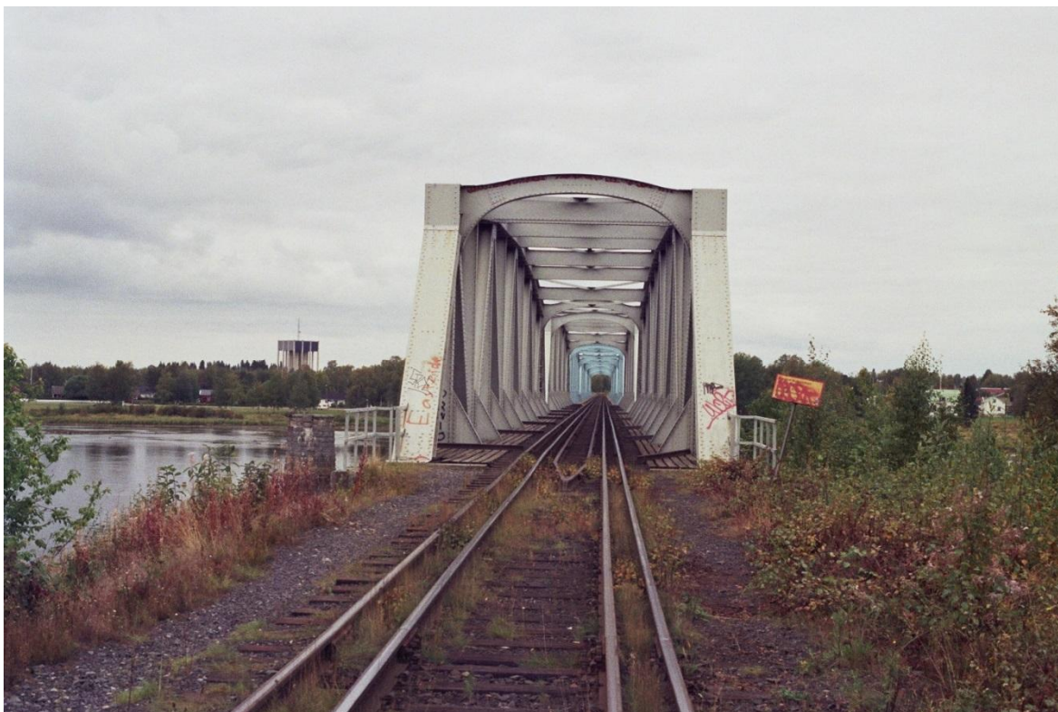
Kuva 2: Suomen ja Ruotsin välinen rautatiesilta Tornionjoen yli Tornion ja Haaparannan välillä. Kiskoparien oikeanpuoliset kiskot kuuluvat Ruotsin 1 435 rataverkkoon ja vasemmanpuoleiset Suomen 1 524 mm rataverkkoon. (Lähde: Wikimedia/Methem)
