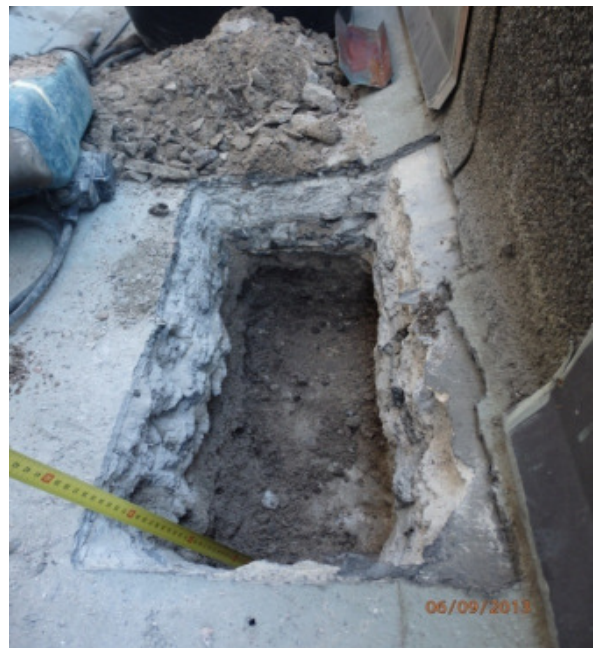
Kuva 11: Lisäkuntotutkimuksessa tehty rakenneavaus.
