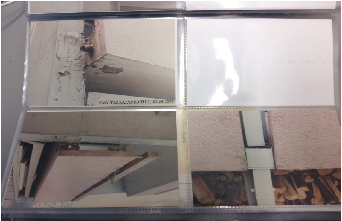
Kuva 5: Esimerkki vuonna 1993 laaditun kuntotutkimusraportin valokuva-liitteestä. (Insinööritoimisto Lauri Mehto Oy)
