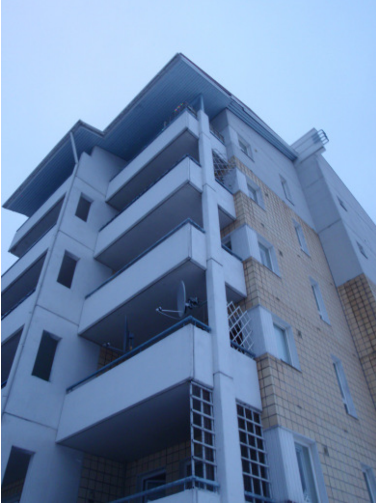
Kuva 20: Yleiskuva kohteen yhden talon julkisivusta ja parvekkeista.
