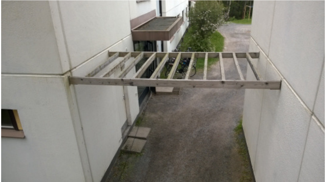
Kuva 13: Rakennusten välinen puukatos vuoden 2014 kuntotutkimuksessa.
