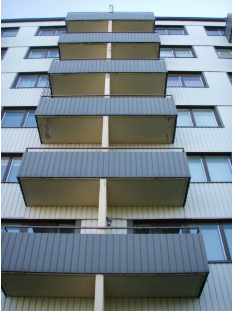
Kuva 23: Yleiskuva kohteen yhdestä parvekelinjasta.
