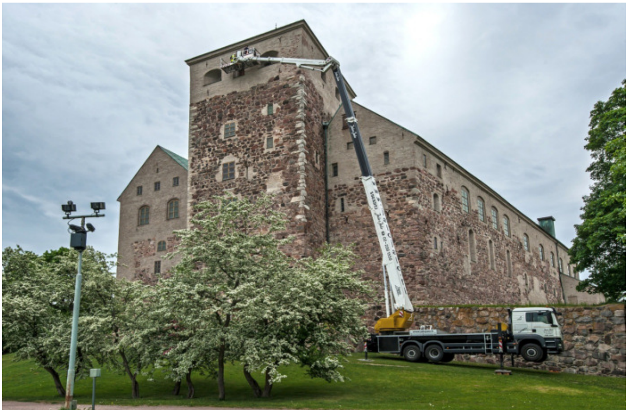
Kuva 1: Kuntotutkimuksen kenttätutkimuksia ja niissä tarvittavaa nostokalustoa.
