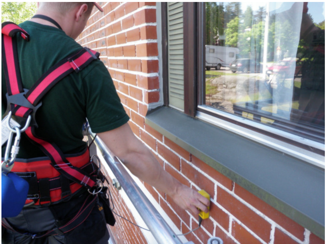
Kuva 2: Kuntotutkija mittaamassa terästen peitepaksuuksia nostokorista käsin.
