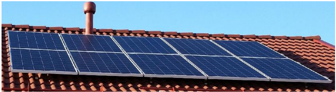
KUVA 13. Aurinkopaneelit asennettu tiilikatolle /13/
