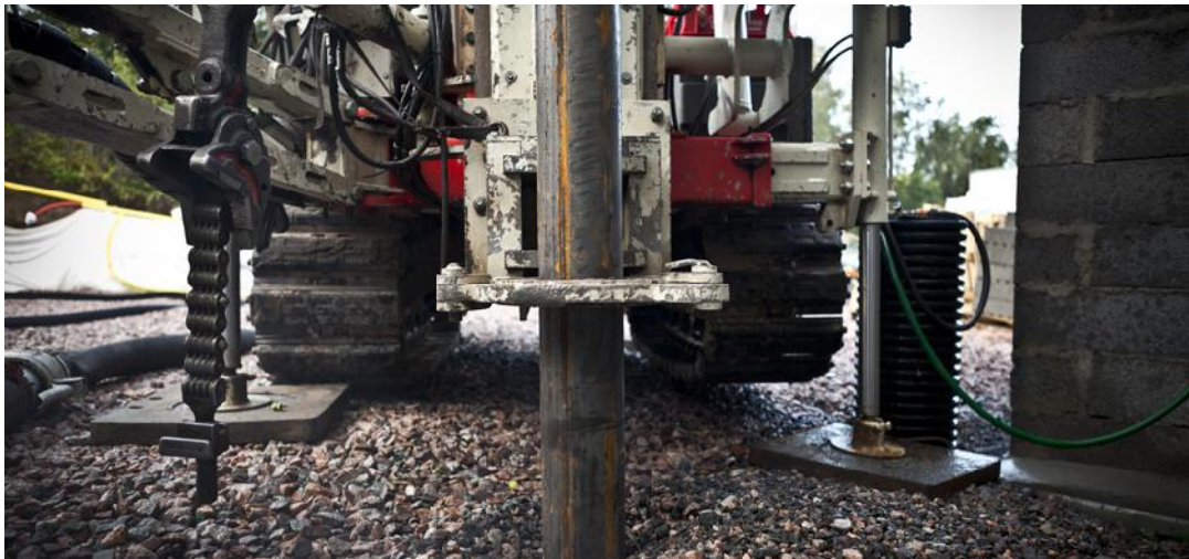
KUVA 7. Maalämpökaivon poraus käynnissä /7/
