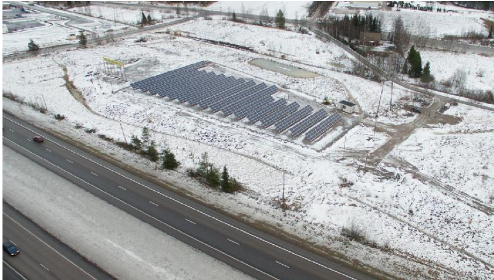
KUVA 12. Keravan Aurinkovoimala Helsinki - Lahti moottoritien varressa 28.1.2016 /12/
