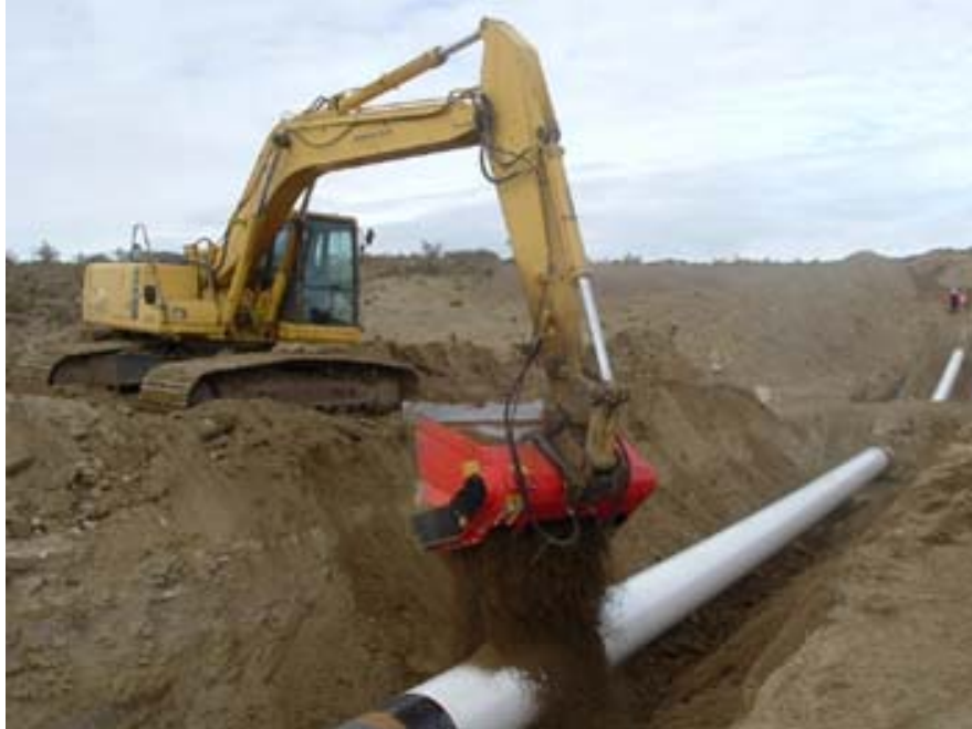
KUVA 2. ALLU SM seulamurskain työskentelemässä
