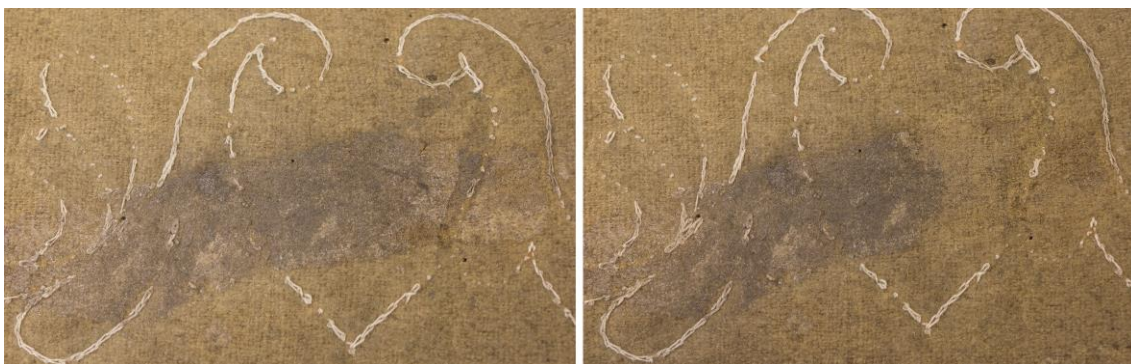
Kuva 30. Tahra imuroinnin jälkeen.
