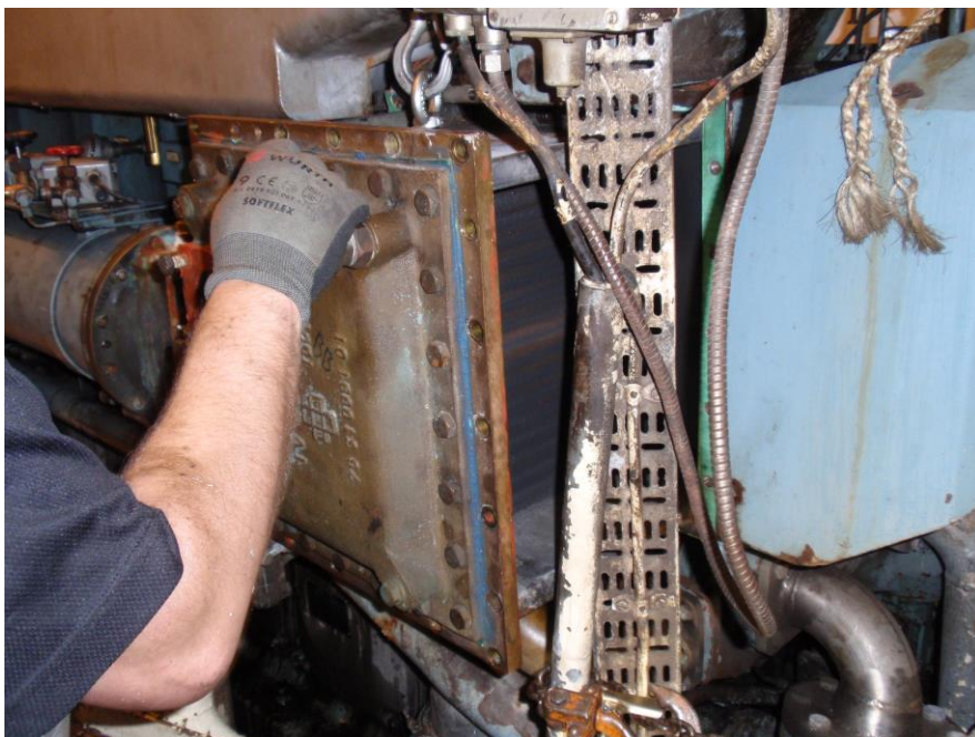
Kuva 6. Pääkone 1:n välijäähdyttimen irrotus.
