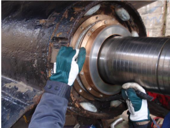
Kuva 17. Cedervall-tiivisteiden asennus potkurilaitteeseen.
