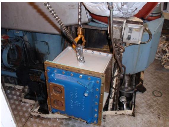
Kuva 10. Pääkone 1:n huolletun välijäähdyttimen asennus.
