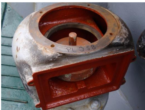
Kuva 30. Painolastitankki 3 SB:n Winel-takaiskuventtiili kunnostettuna.
