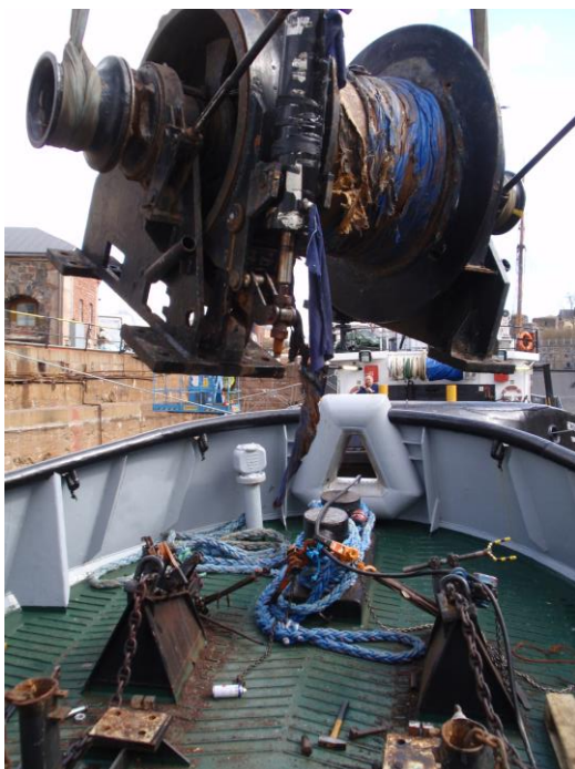
Kuva 25. Vanhan hinausvinssin poisto.
