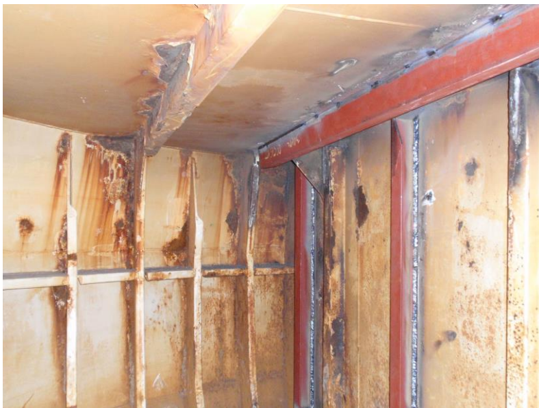
Kuva 20. Painolastitankin 4BB korjaus kesken.
