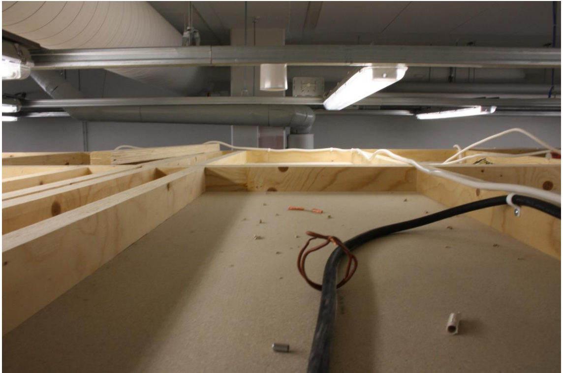
KUVA 18. Asennusseiniä yläpuoli. Työsali S4039
