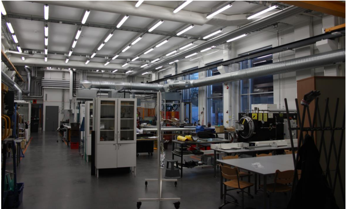
KUVA 19. Yleisnäkymä työsalin S1019
