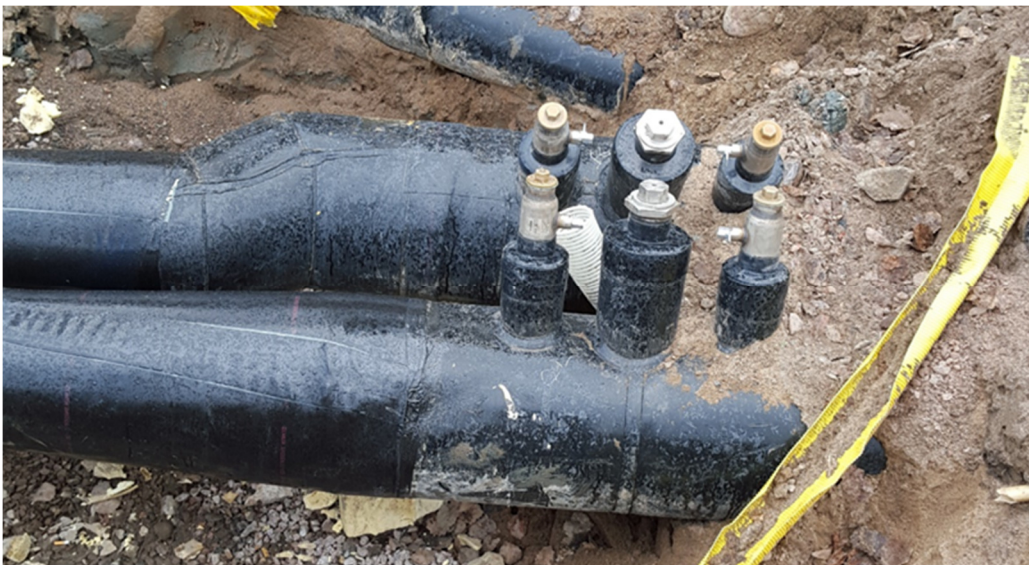
Figur 19: Nya ventiler klara för användning.
