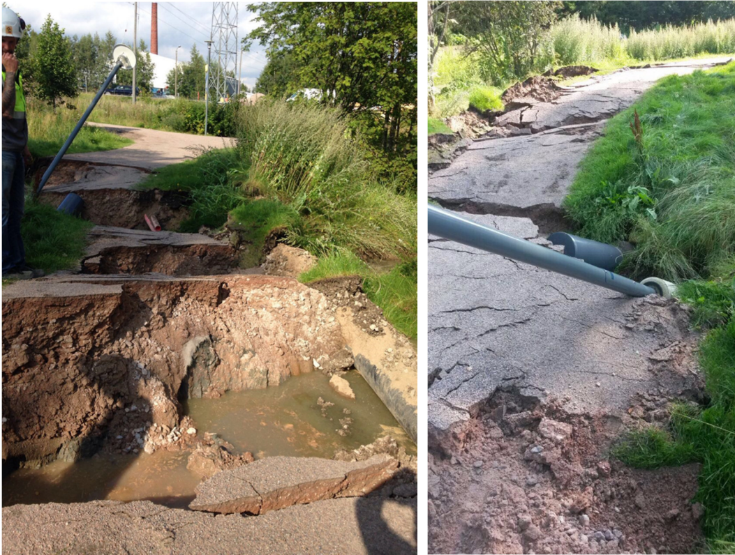
Figur 26: Den gamla linjen gick under gångvägen i Lasimäki. Skador orsakade av jordrasen år 2015.
