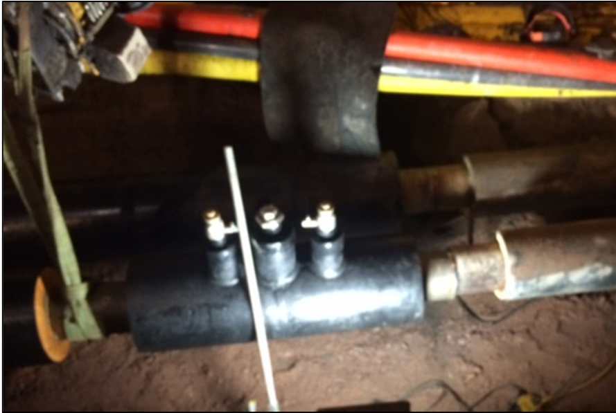
Figur 22: Nya ventilers placering före svetsande.
