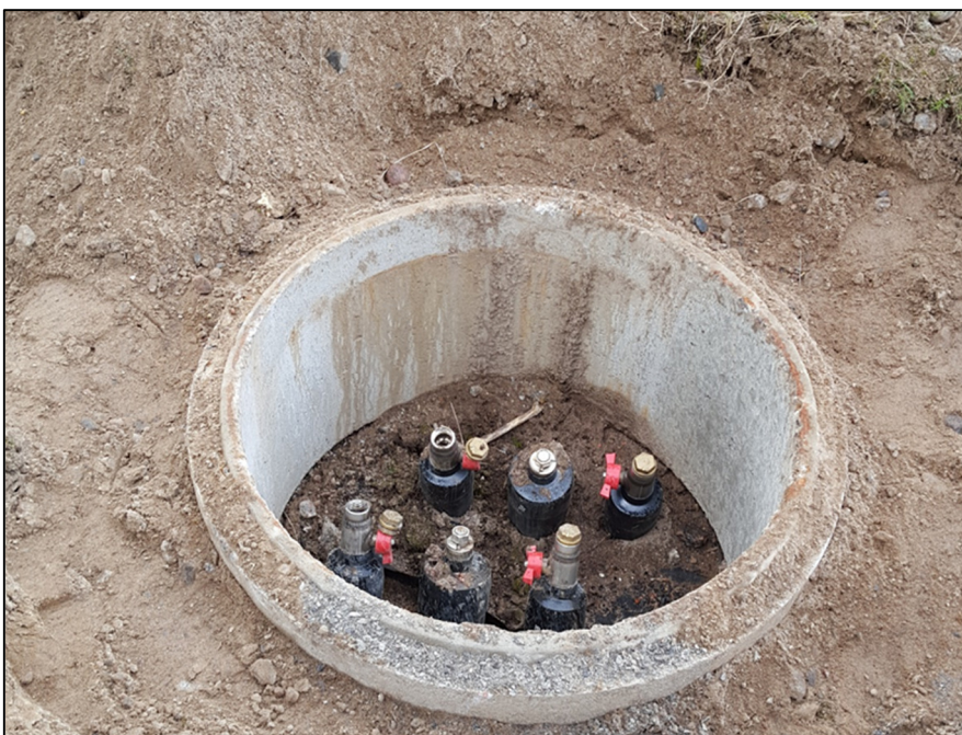
Figur 15: Markventilbrunnen dokumenteras i datasystemet för framtiden.
