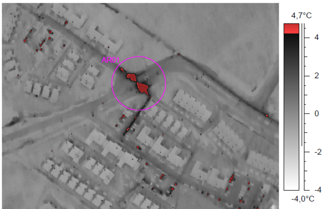
Figur 14: Ett läckage i fjärrvärmenätet i en värmekamerabild från en helikopter.
