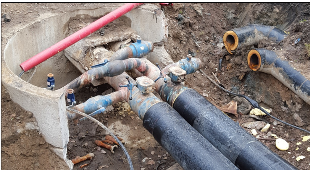
Figur 23: Byte av ventiler och onödig fjärrvärmelinjes avkapning.
