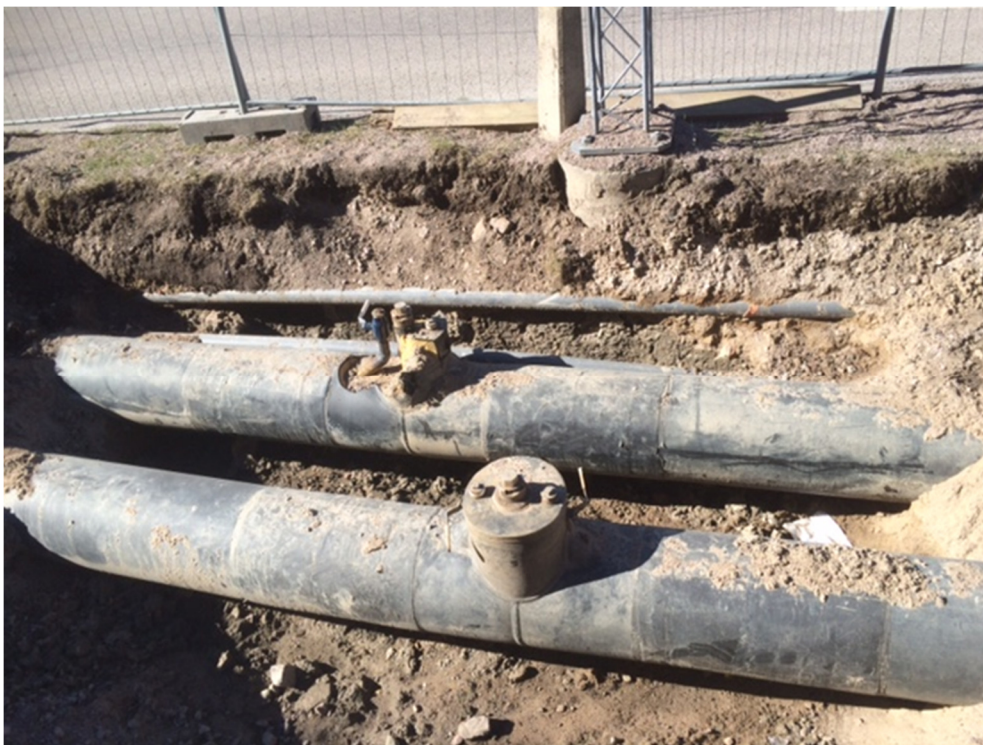
Figur 21: Ventilerna och röret framgrävt och färdigt för reparation.
