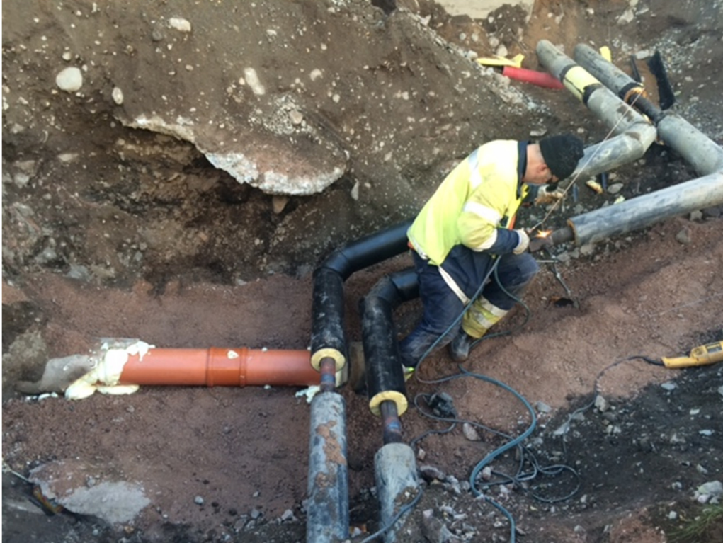
Figur 24: Installationer på gång.
