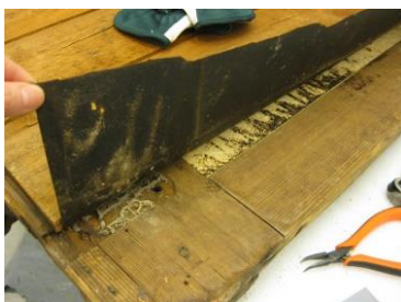
Kuva 62. Paneelien alta paljastui lastulevyä.
