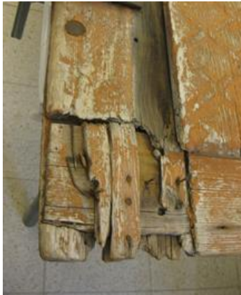
Kuva 69. Vasemman liitoksen etupuoli.
