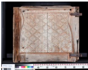
Kuva 43. Oikea alaovi edestä. Takakuva liitteessä 1. Korkeus 63 cm, leveys 76 cm. Paksuusmitta kehyspuusta 3,5 cm ja paneelien kanssa paksuus 5 cm. Korkein kohta ovesa on vesilistan kohdalla 8 cm.
