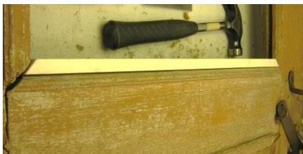
Kuva 74. Pontissa ei ollut jäljellä etuosaa, joten veistin ja liimasin siihen uuden.
