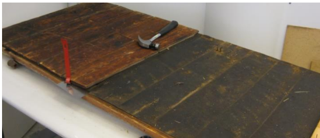
Kuva 45. Paneelien ja peilioven välissä oleva bitumipaperi.
