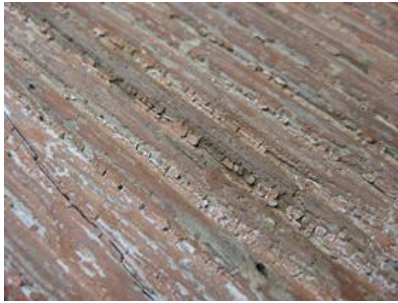
Kuva 48. Krakeloitunutta maalipintaa.
