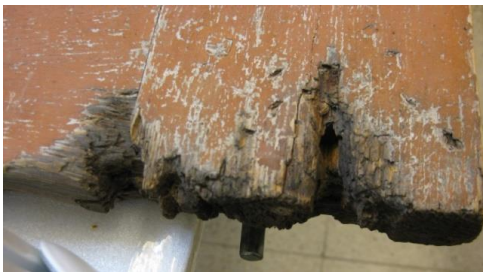
Kuva 68. Tähän ison susioven yläosan kulumakohtaan en tehnyt puukorjauksia.
