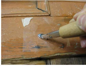
Kuva 60. Maalinkiinnitystä lämpöpusikan avulla.
