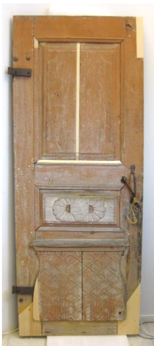
Kuva 75. Ison oven puukorjaukset.
