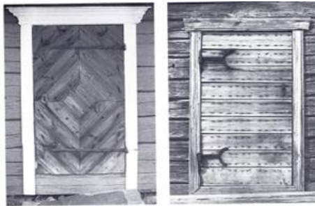
Kuva 4. Paneeliovia. Isokyröläinen vilja-aitan ovi vasemmalla ja oikealla ruoka-aitan ovi Posiolta (Kolehmainen 1998, 106).
