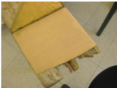
Kuva 71. Liimasin paksua pyökkiviilua poikkisyin kehyspuun syysuuntaan nähden, jotta se tukisi liitoksen puun halkeamia.
