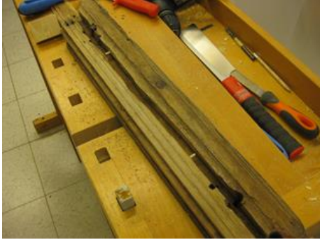
Kuva 66. Lisäsin vesilistan halkeamaan tukitapit.
