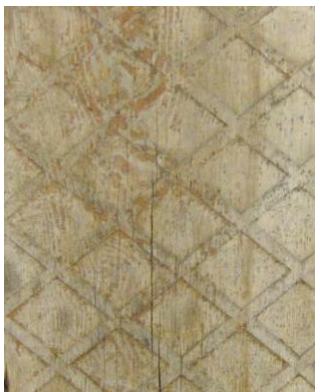
Kuva 49. Puuttuva maalipinta.
