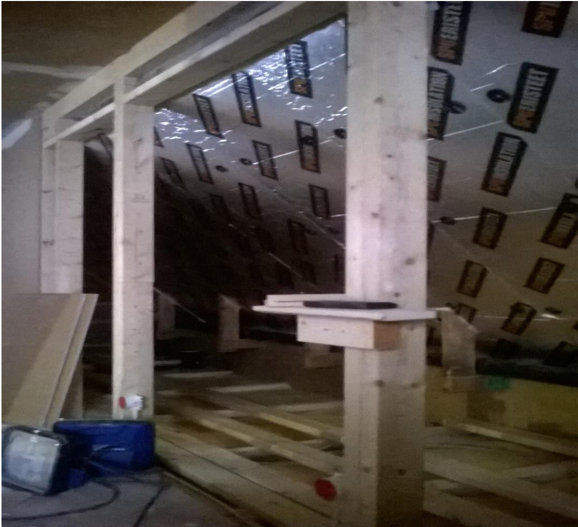
KUVA 12. Valmiiksi asennetut Kingspan-eristeet vaatehuoneessa
