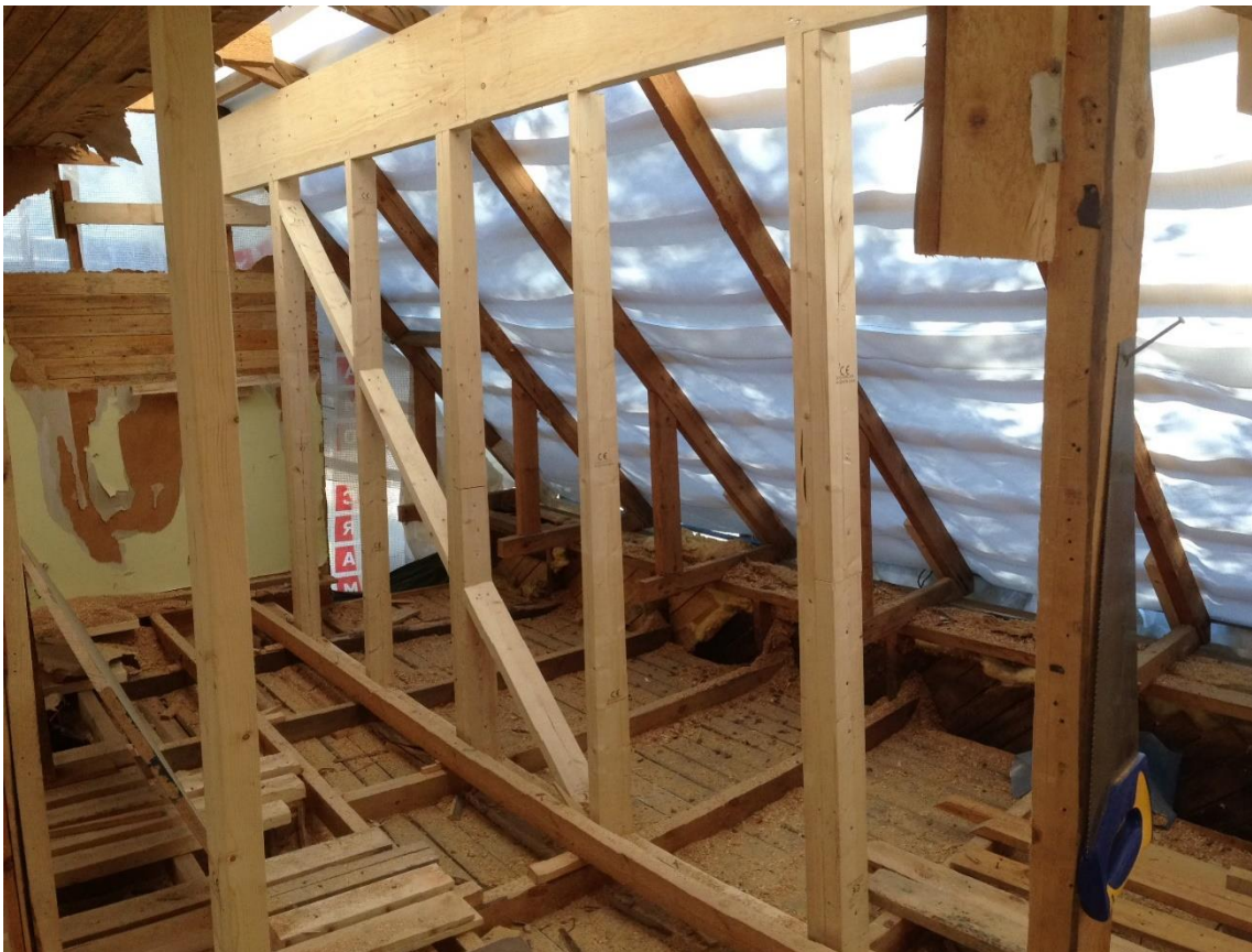
KUVA 16. Laajennusosan yläpohjan pilari-palkki-rakenne
