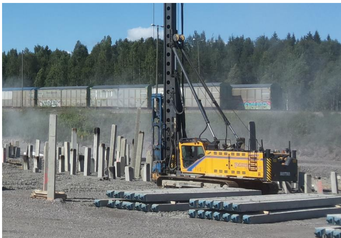
Kuva 9. Paalutustyömaa (Jyri Hyvönen)
