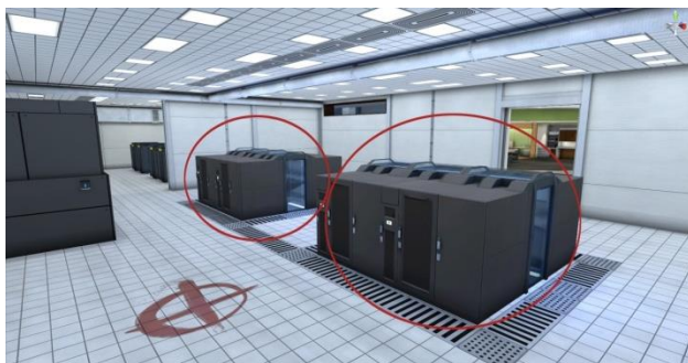
Kuva 7. Propeista tehdyt suojat Bureaussa.
